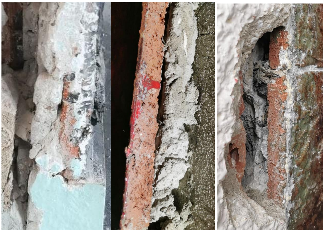
Fot. 9-11. Montaż płyt kompozycji (odpowiednio 1, 4, 3) na zaprawie cementowej. Fot. D. Białek-Kostecka, marzec 2024
