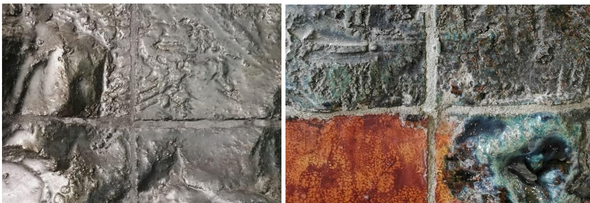
Fot. 12-13. Spoinownie pokryte warstwą malarską (mozaika 1, po lewej stronie) i pozostawione w naturalnym kolorze zaprawy cementowej (mozaika 4, po prawej stronie). Fot. D. Białek-Kostecka, marzec 2024
