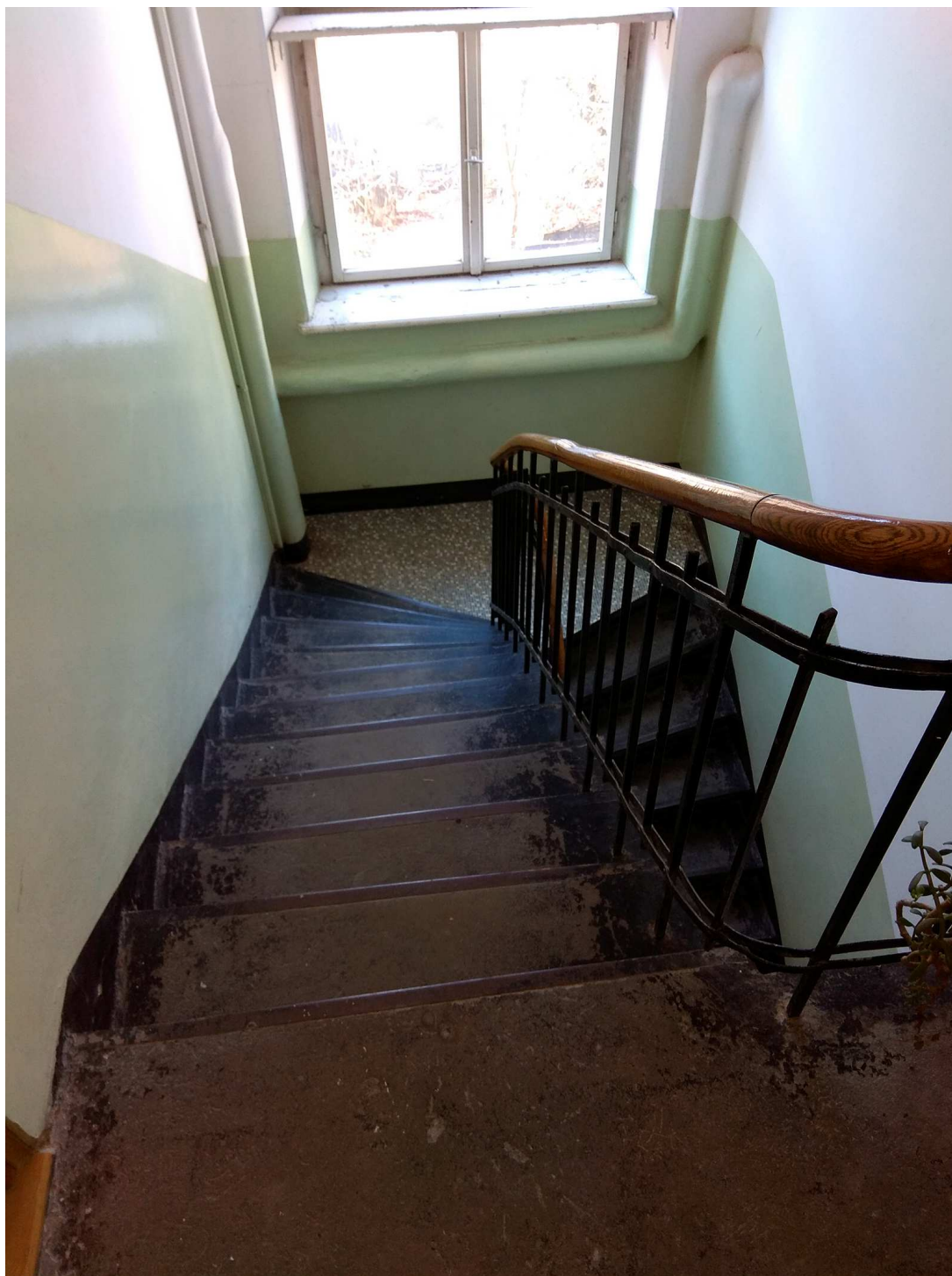
posadzka tylnej klatki schodowej
