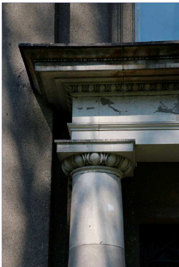
zniszczenia tynków / kamienia (portal) wskutek umieszczonych obróbek blacharskich; brak części szyb w okienku strychowym; założenie nakropu na elementach rzeźbiarskich spływające rysunek profilu zniszczenia kamiennego cokołu w dolnych partiach elewacji
