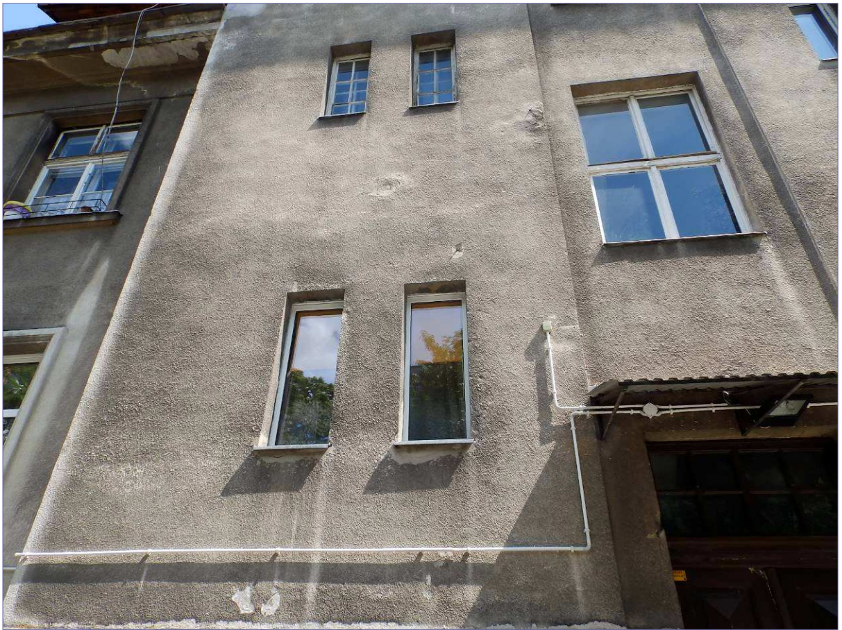
degradacja tynków w miejscach zniszczonych obróbek blacharskich i pod dachem, lokalnie występujące naprawy z użyciem szarej zaprawy mineralnej
