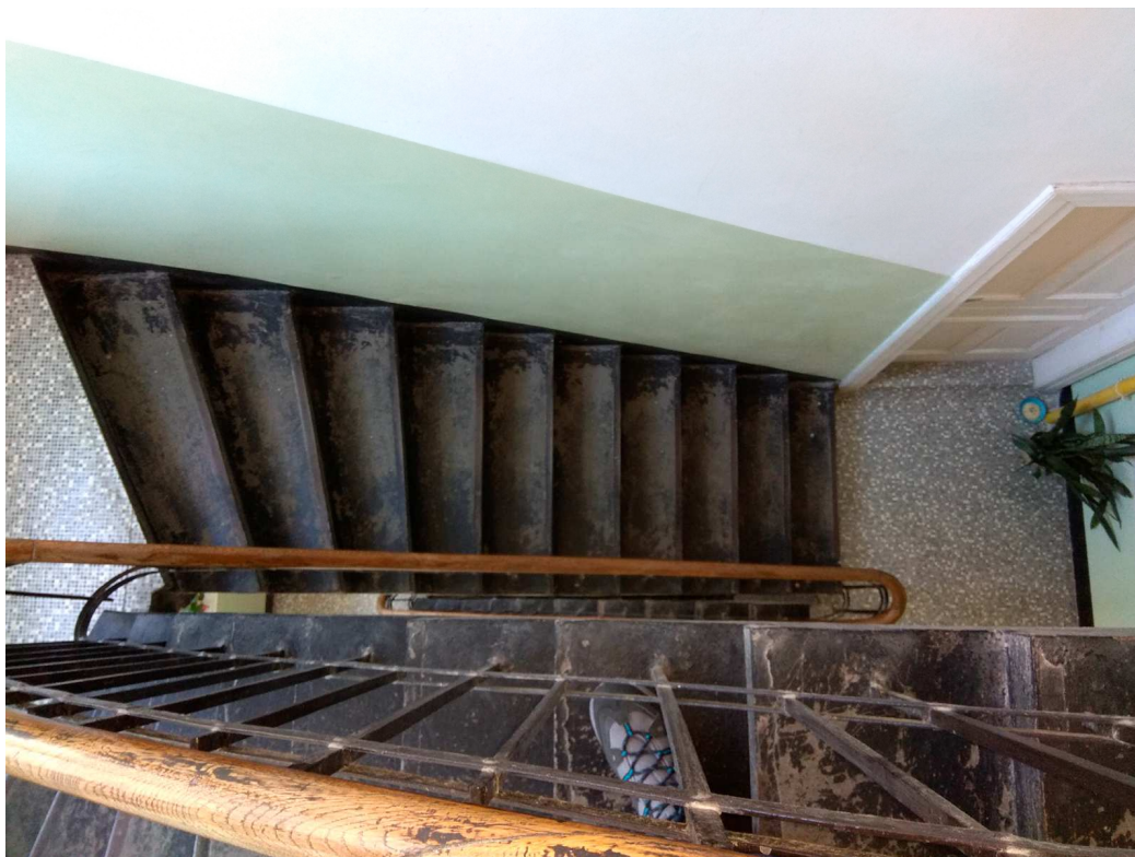
balustrada i okładziny tylnej klatki schodowej
