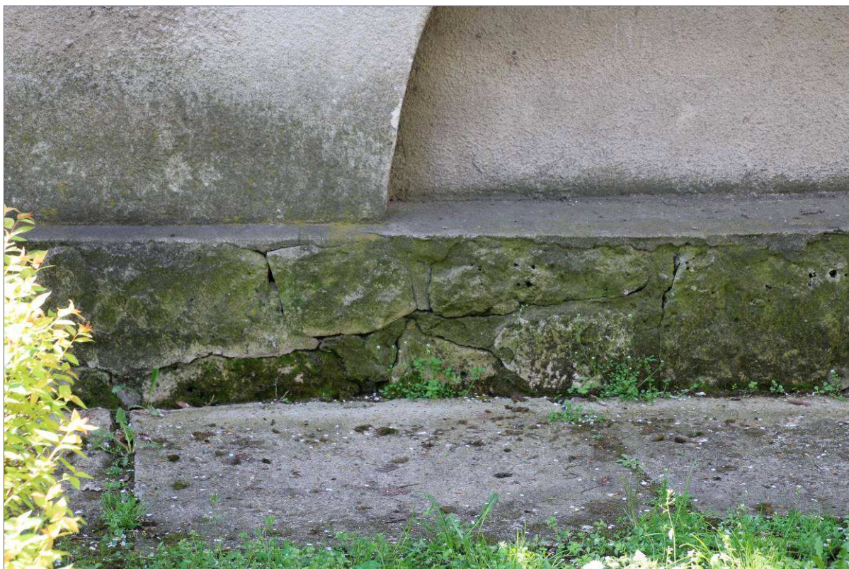
zniszczenia kamiennego cokółu w dolnych partiach elewacji- brak spoinowania; lokalnie występujące zacierki; znaczna degradacja wskutek korozji biologicznej w miejscach mocno zacienionych; liczne zaprawy naprawcze w miejscach skrzynek technicznych
