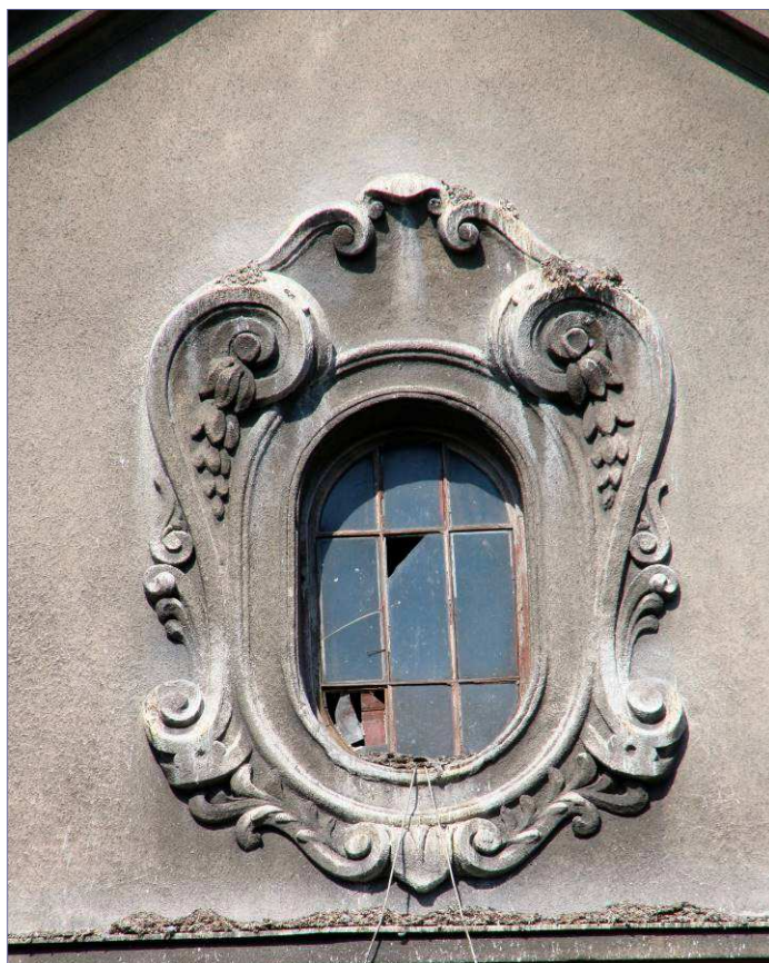
zniszczenia tynków / kamienia (portal) wskutek umieszczonych obróbek blacharskich; brak części szyb w okienku strychowym; założenie nakropu na elementach rzeźbiarskich spływające rysunek profilu zniszczenia kamiennego cokołu w dolnych partiach elewacji
