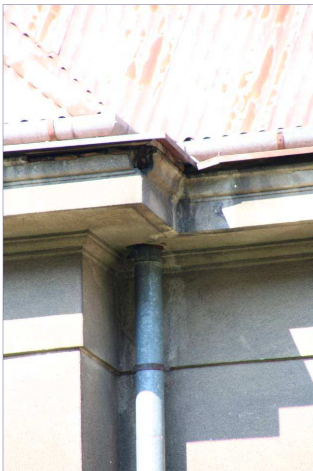
zniszczenia tynków / kamienia (portal) wskutek umieszczonych obróbek blacharskich; brak części szyb w okienku strychowym; założenie nakropu na elementach rzeźbiarskich spływające rysunek profilu zniszczenia kamiennego cokołu w dolnych partiach elewacji
