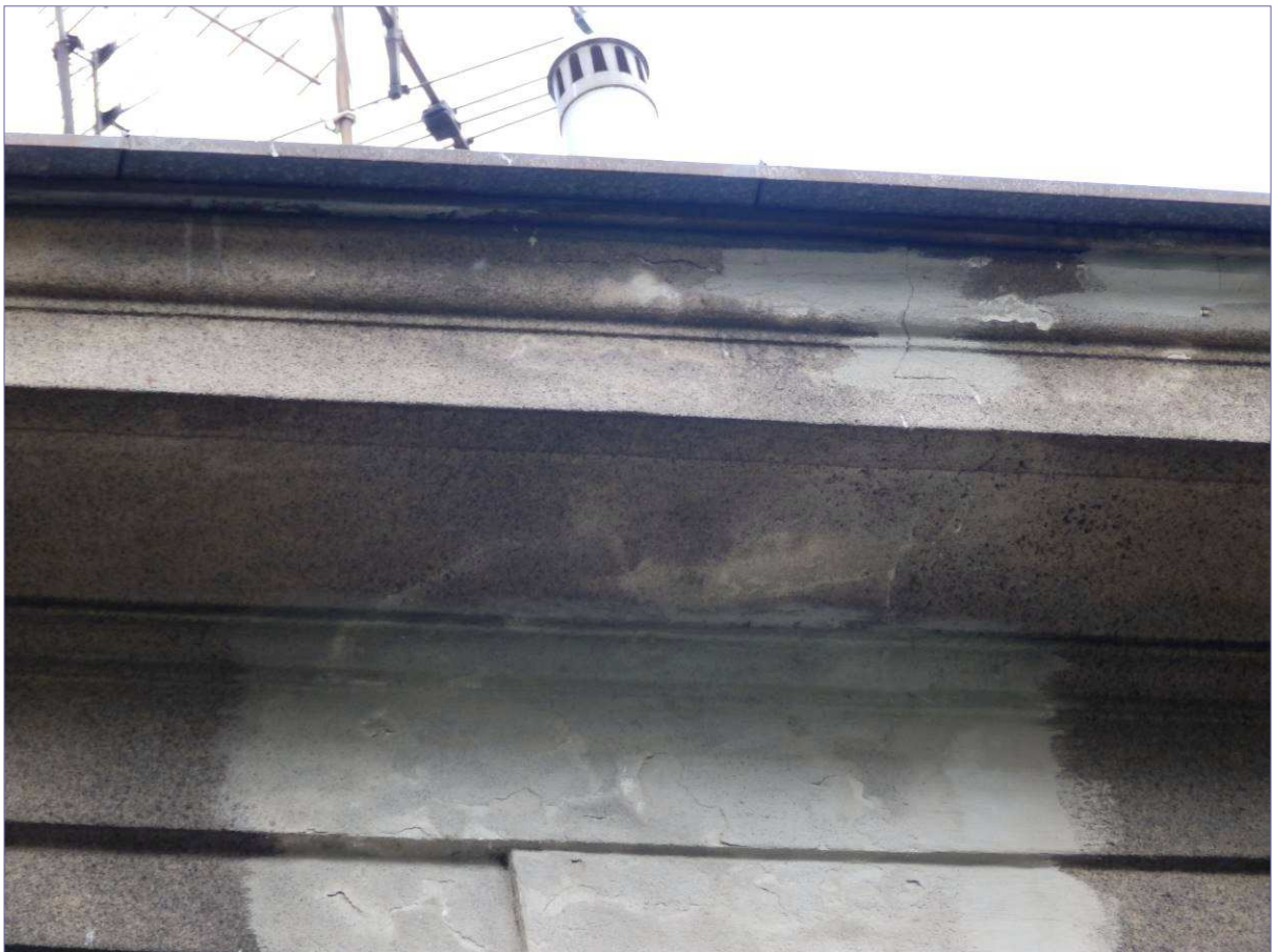
degradacja tynków w miejscach zniszczonych obróbek blacharskich i pod dachem, lokalnie występujące naprawy z użyciem szarej zaprawy mineralnej
