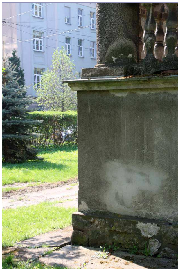
zniszczenia tynków / kamienia (portal) wskutek umieszczonych obróbek blacharskich; brak części szyb w okienku strychowym; założenie nakropu na elementach rzeźbiarskich spływające rysunek profilu zniszczenia kamiennego cokołu w dolnych partiach elewacji
