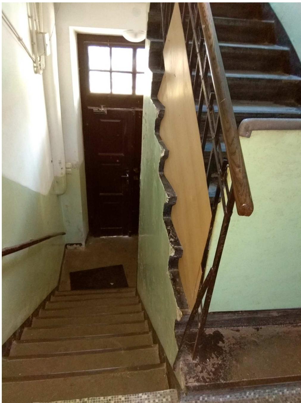
widok drzwi wejściowych do tylnej klatki schodowej
