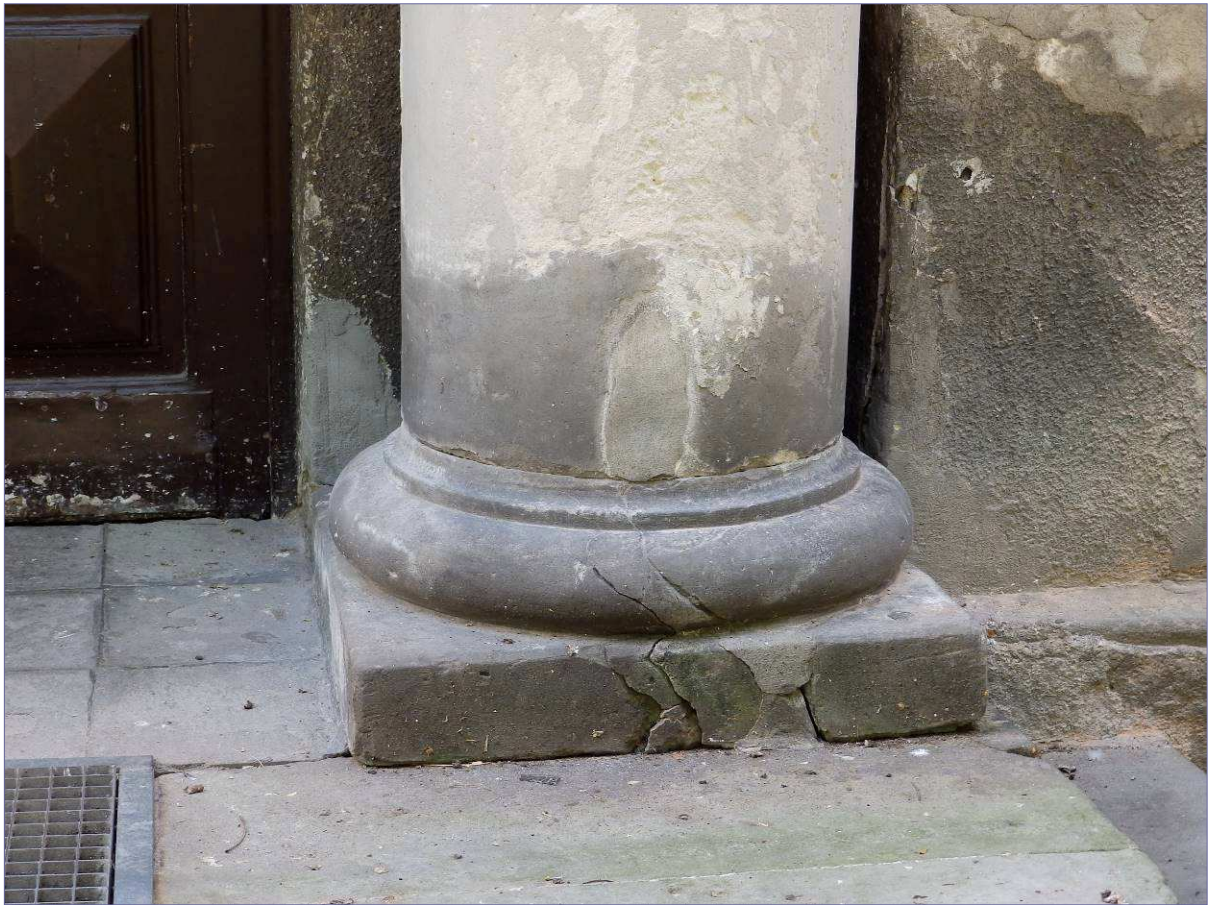
Spękania podstawy i bazy kamiennej kolumny przed głównym wejściem do willi; prowizoryczne naprawy zaprawą cementową, zabrudzenie powierzchni kamienia; zagrzybienie dolnych części oraz zasolenie, uszkodzona kamieniarka w partii pod kamiennym gzymsem wskutek nieuszczelności obróbki blacharskiej; liczne kable i instalacje przyłączone do elewacji
