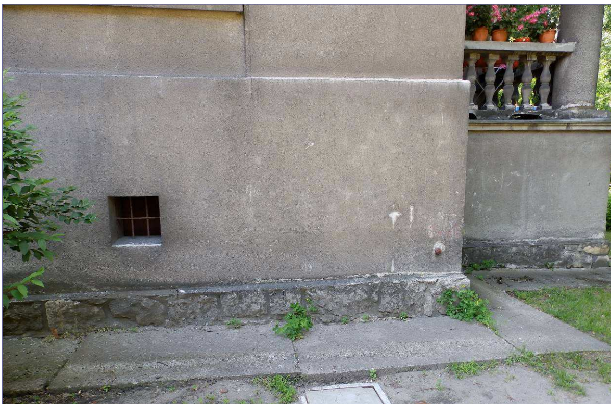
kamienny niski cokolik, tynki cementowego nakropu na całości elewacji
