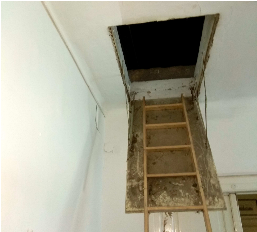
istniejący wylaz na strych
