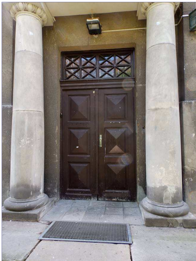
Spękania podstawy i bazy kamiennej kolumny przed głównym wejściem do willi; prowizoryczne naprawy zaprawą cementową, zabrudzenie powierzchni kamienia; zagrzybienie dolnych części oraz zasolenie, uszkodzona kamieniarka w partii pod kamiennym gzymsem wskutek nieuszczelności obróbki blacharskiej; liczne kable i instalacje przyłączone do elewacji
