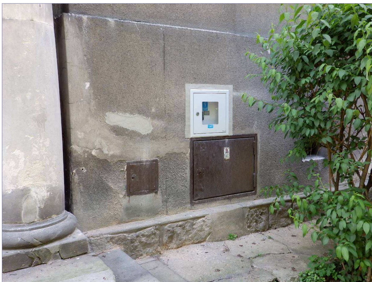
zniszczenia kamiennego cokółu w dolnych partiach elewacji- brak spoinowania; lokalnie występujące zacierki; znaczna degradacja wskutek korozji biologicznej w miejscach mocno zacienionych; liczne zaprawy naprawcze w miejscach skrzynek technicznych
