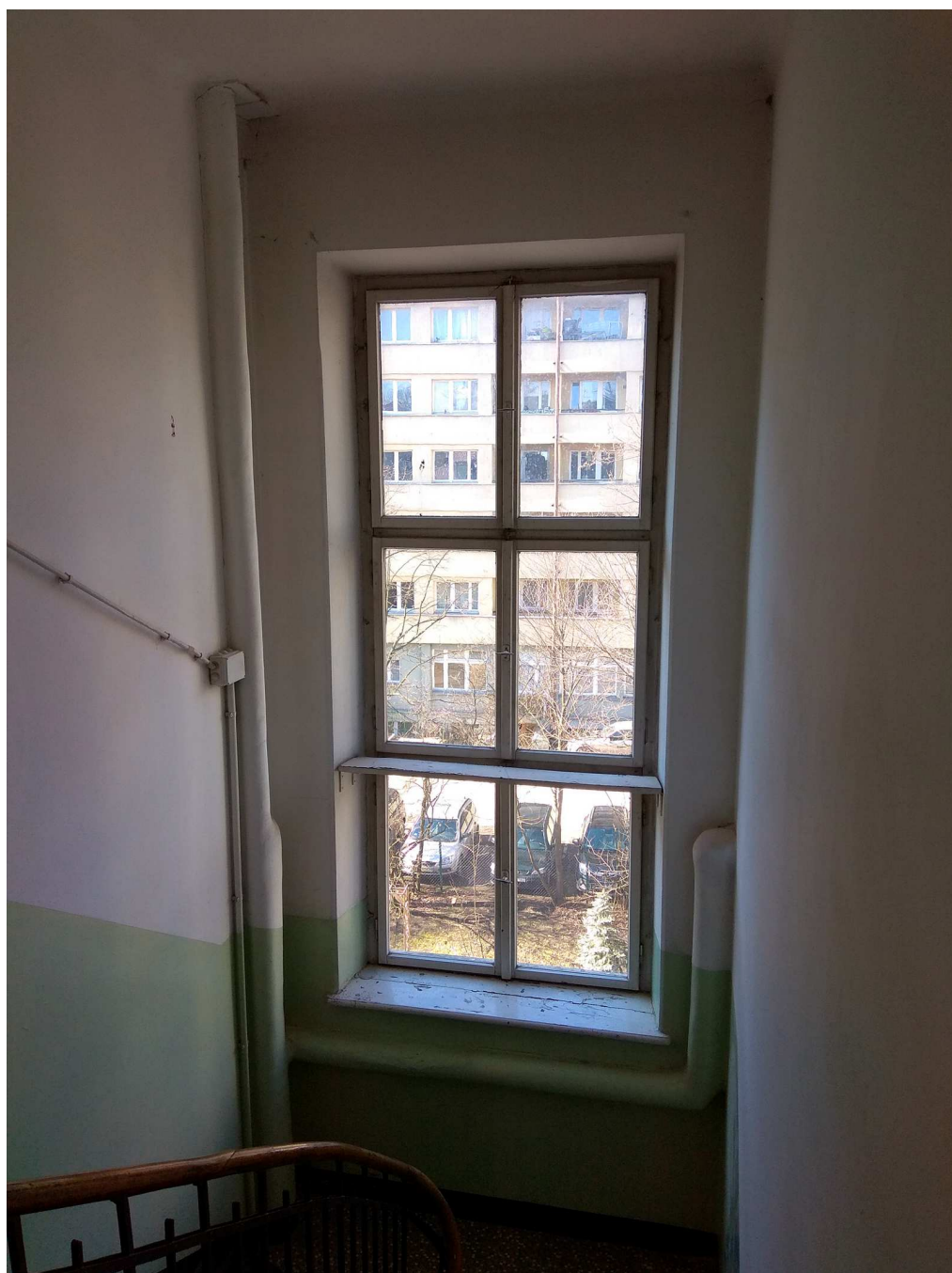
strop nad tylną klatką schodową w miejscu przewidywanego komina dla klapy oddymiającej
