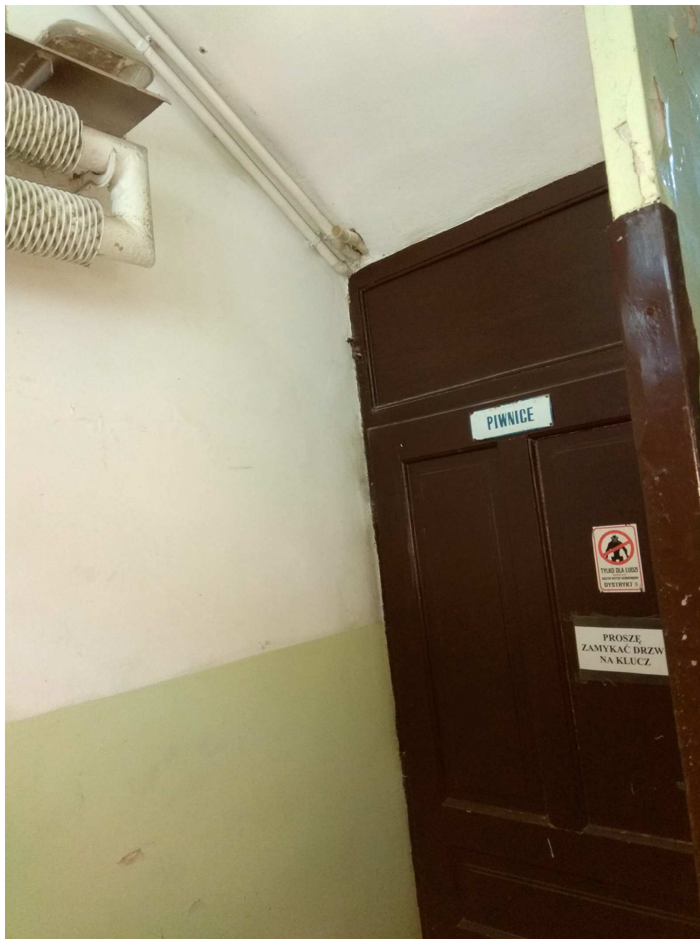
istniejące drzwi do piwnicy
