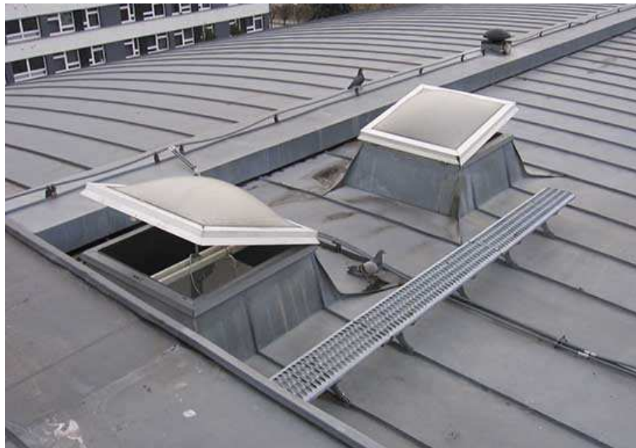
foto. istniejące klapy świetlików. Nieprawidłowo wykonane obróbki cokołów typu komin. Wykonano z 1 arkusza blachy
