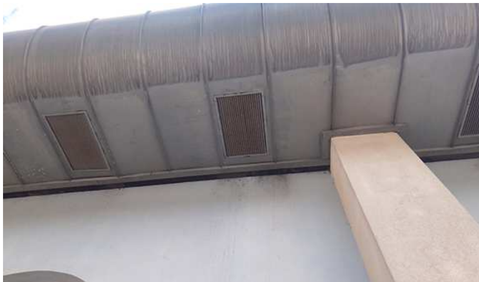
foto. widok istniejące wyoblenie okapu w miejscu z kratami wentylacyjnymi.
