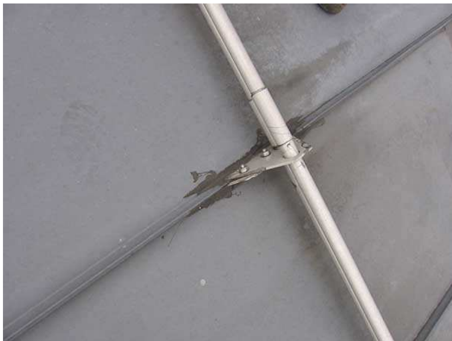
foto. widok istniejące mocowania bariery śniegowej podwójnej, na dachu łukowym, uszkodzone, pęknięta blacha pod rąbkiem zaklejona żywicą
