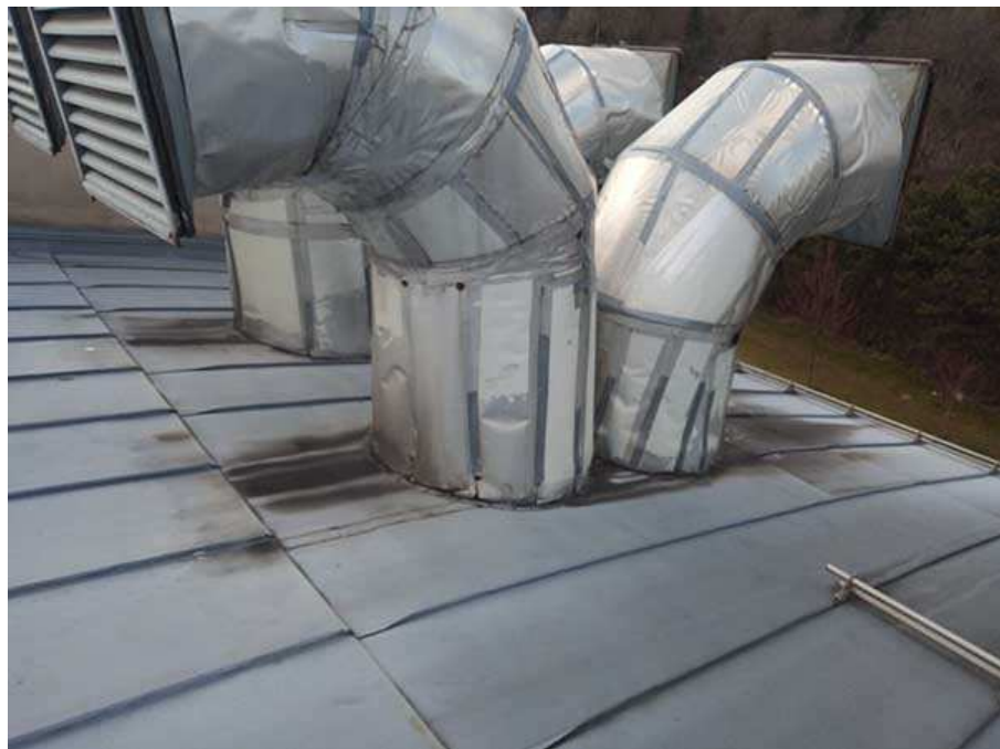
foto. istniejące klapy świetlików. Nieprawidłowo wykonane obróbki cokołów typu komin. Wykonano z 1 arkusza blachy
