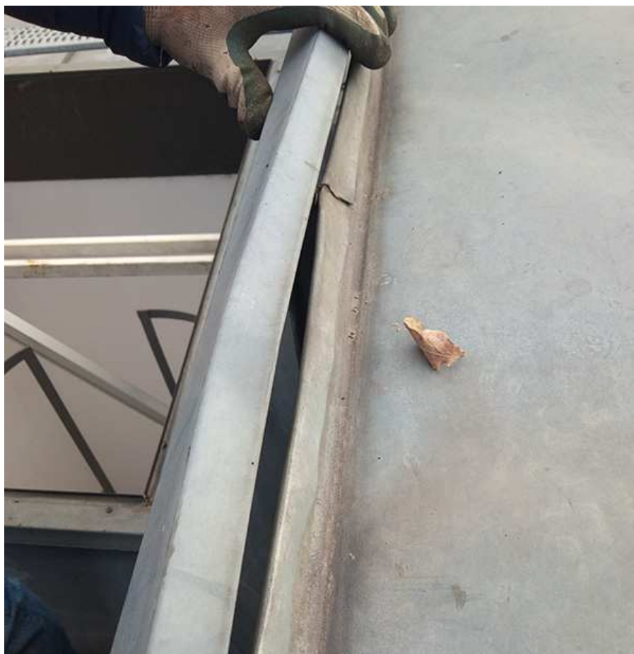
foto. widok istniejąca obróbka boczna – wiatrownica boczna dachu pulpitowego. Złe zamocowanie blachy wiatrownicy, brak elementów usztywniających.
