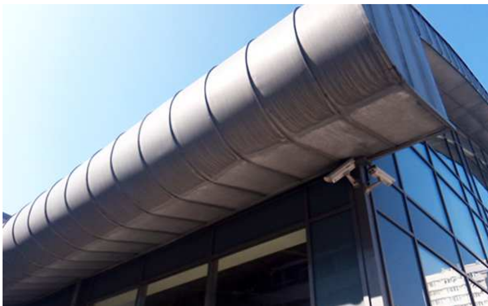
foto. widok istniejące wyoblenie okapu w miejscu z kratami wentylacyjnymi.
