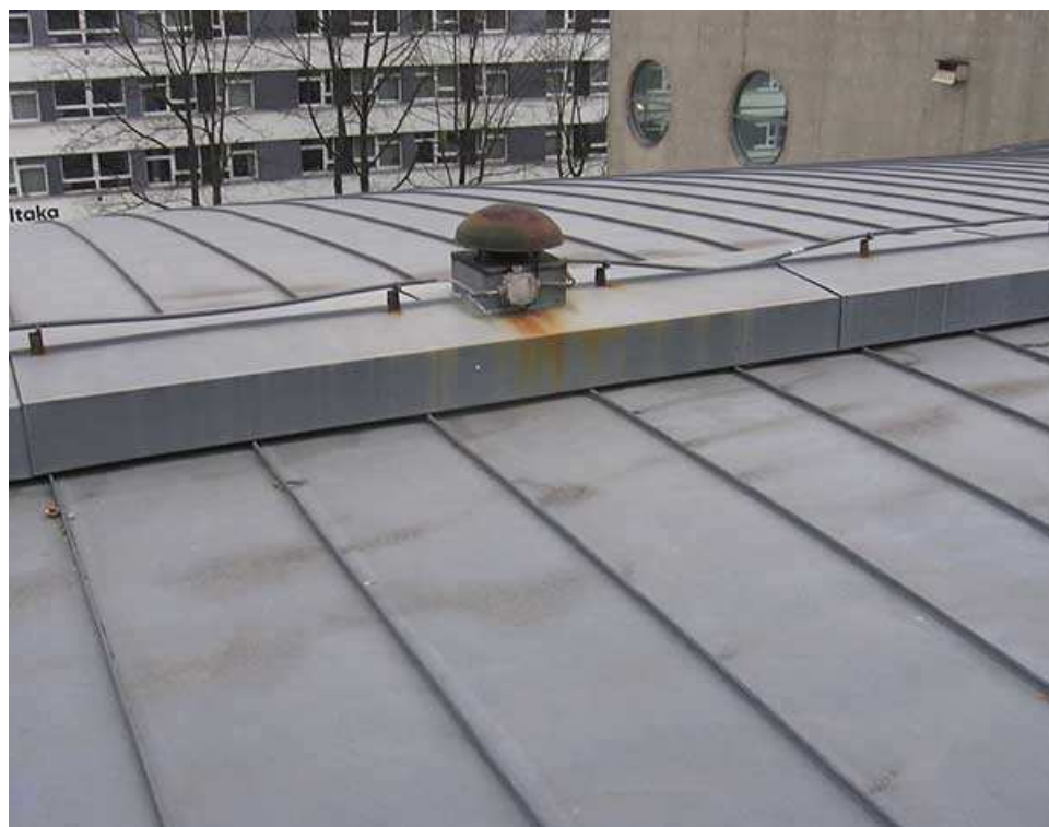
foto. widok istniejący wentylator na obróbce kalenicowej połaci
