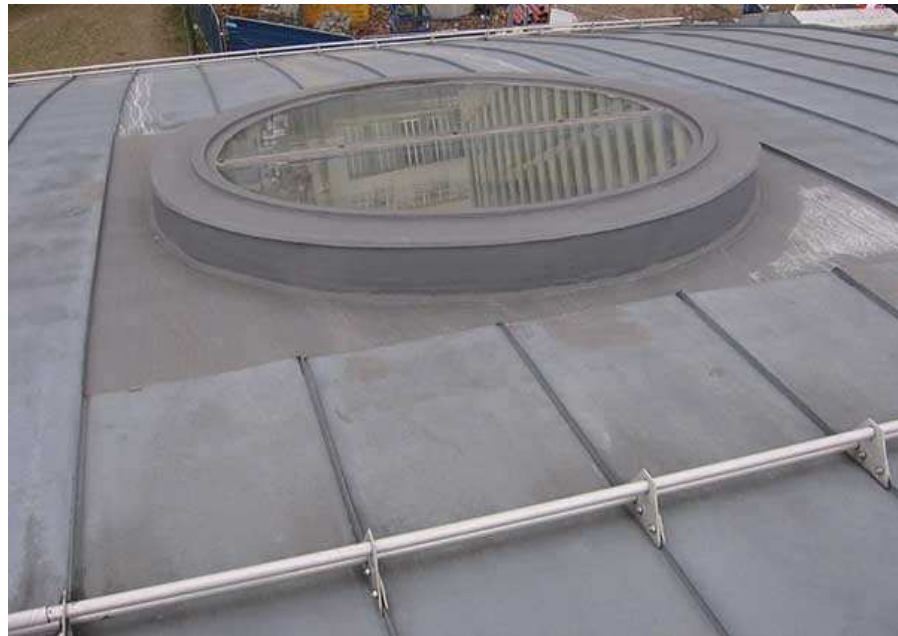
foto. widok istniejące okno w połaci łukowej dachu typu bulaj, widoczne reperowane żywicą.
