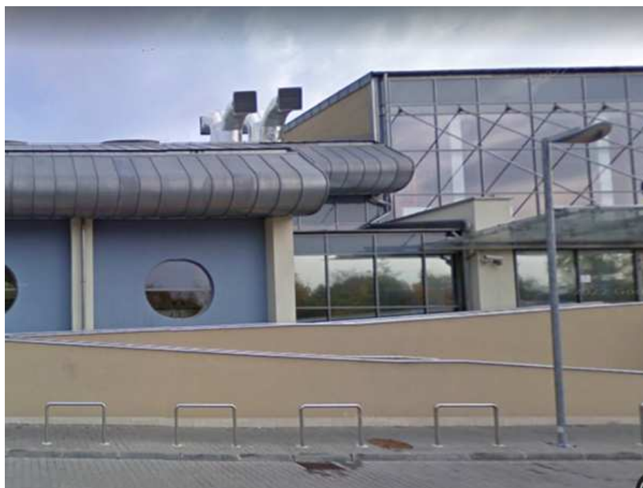
foto. widok istniejące wyoblenia okapów z lewej strony wejścia głównego.
