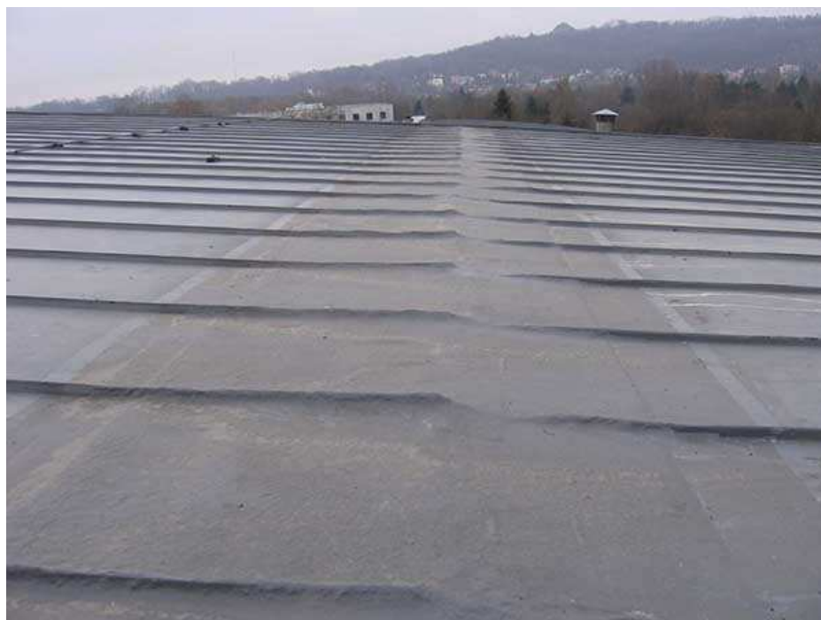
foto. widok istniejące łączenie arkuszy blachy w części pulpitowej dachu, reperowane żywicą
