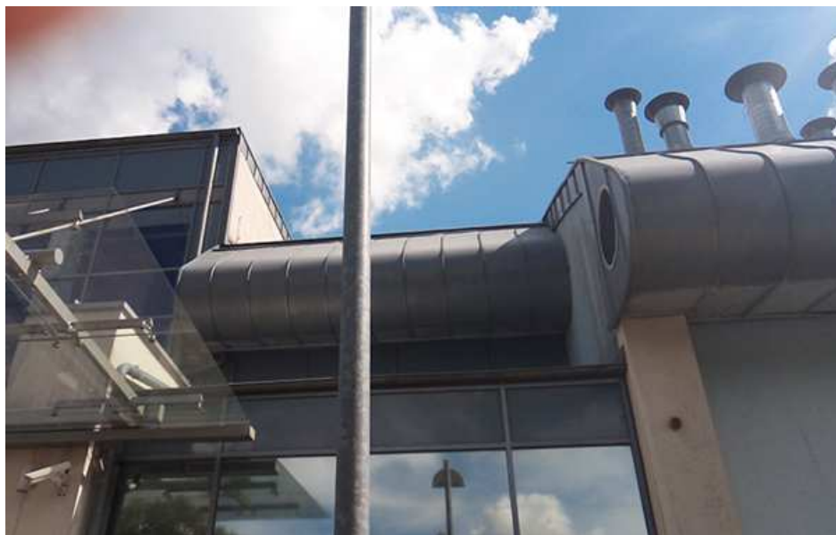
foto. widok istniejące wyoblenia okapów z prawej strony wejścia głównego.
