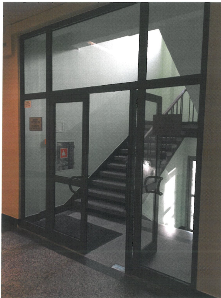
Rys. 14. Wydzielenie przeszkleniem bezklasowym środkowej klatki schodowej (klatka 3) w budynku C-2.
