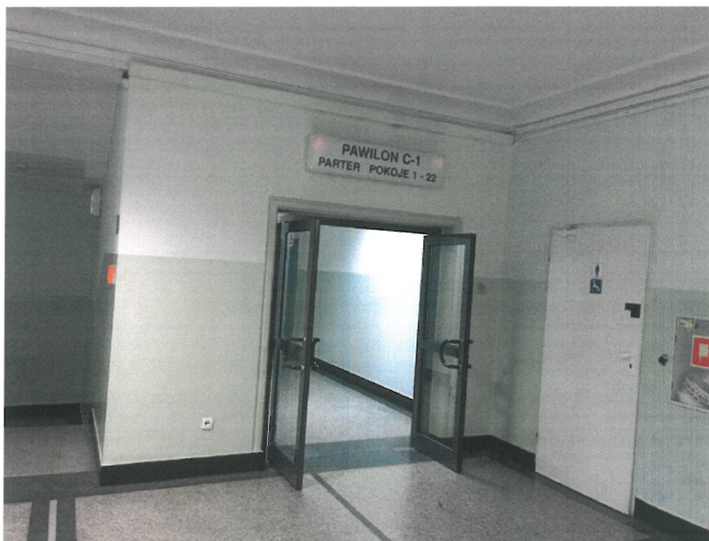
Rys. 12. Oddzielenie drzwiami bezklasowymi klatki schodowej 2 w budynku C-2 od budynku C-1.
