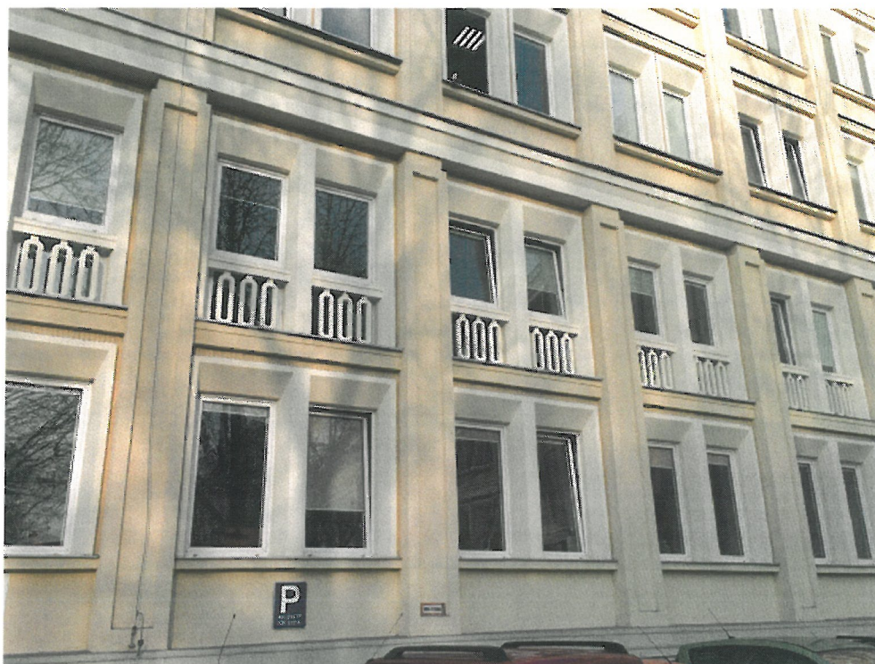
Rys. 7. Rysunek pokazuje brak pasa międzykondygnacyjnego w budynku C-2 pomiędzy kondygnacjami I i II.
