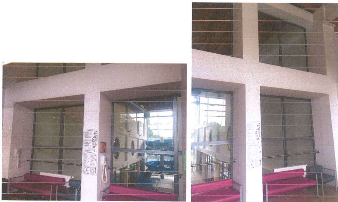
Rys.7. Bezklasowa obudowa drogi ewakuacyjnej na kondygnacji II.
