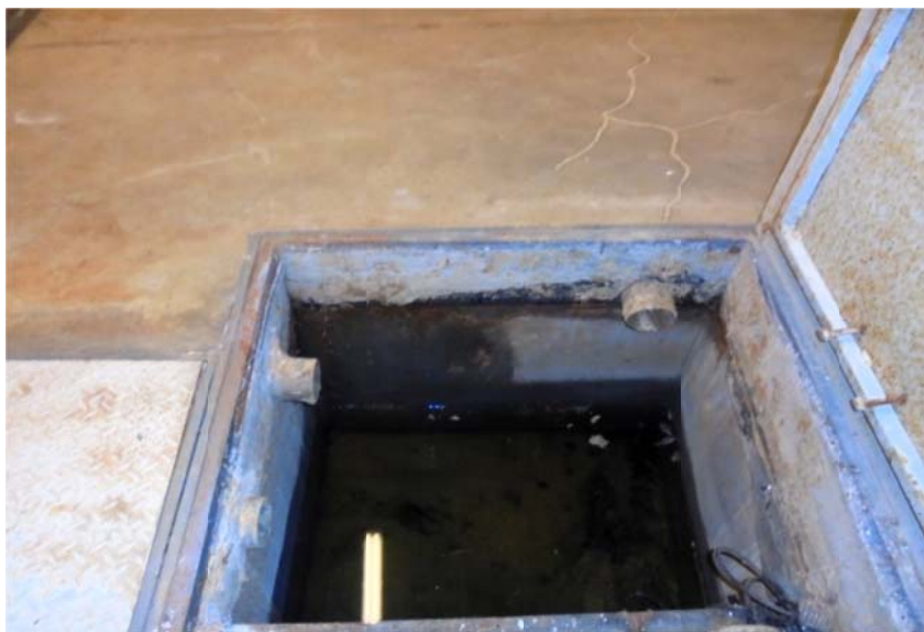
Fot.1 Studzienka w wymiennikowni, wyciek spod posadzki, woda na dnie
