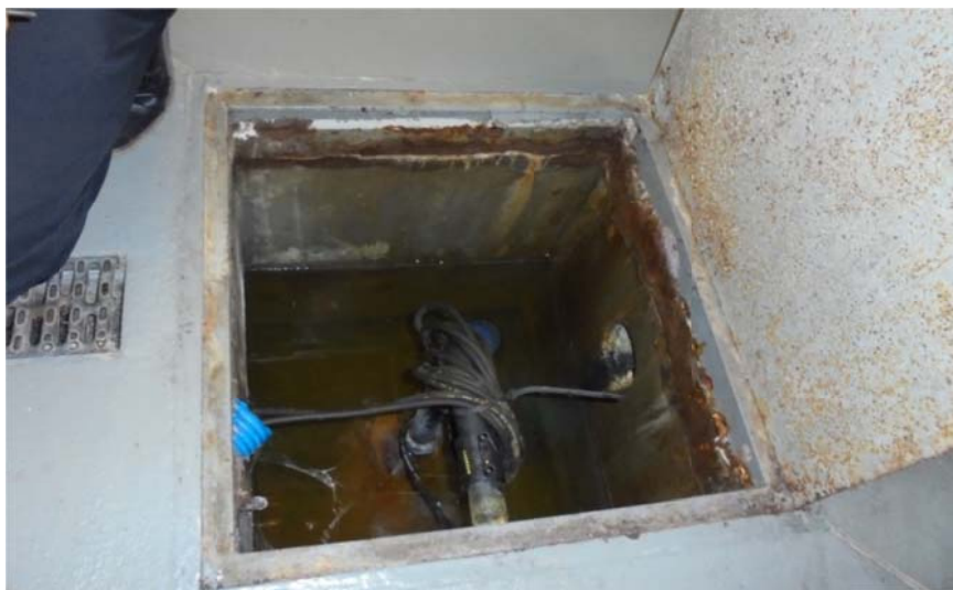
Fot.2 Studzienka w klimatyzatorni, wyciek spod posadzki, woda stojąca na dnie
