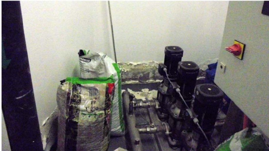
Fot.5 Zawilgocony dół ściany w pomieszczeniu technicznym
