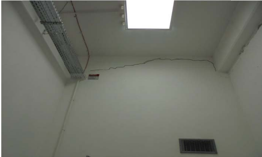
Fot.7 Rysa na murze pod stropem
