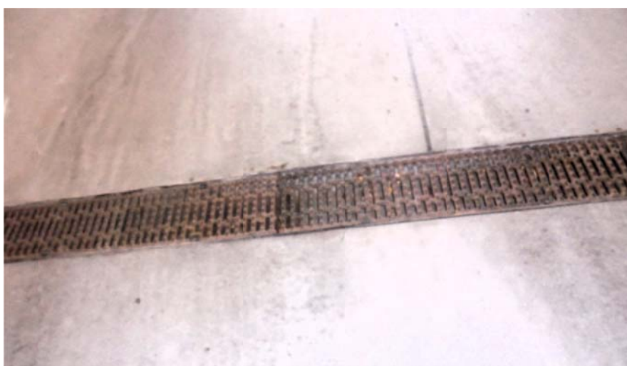
Fot.4 Odwodnienie liniowe powyżej poziomu posadzki
