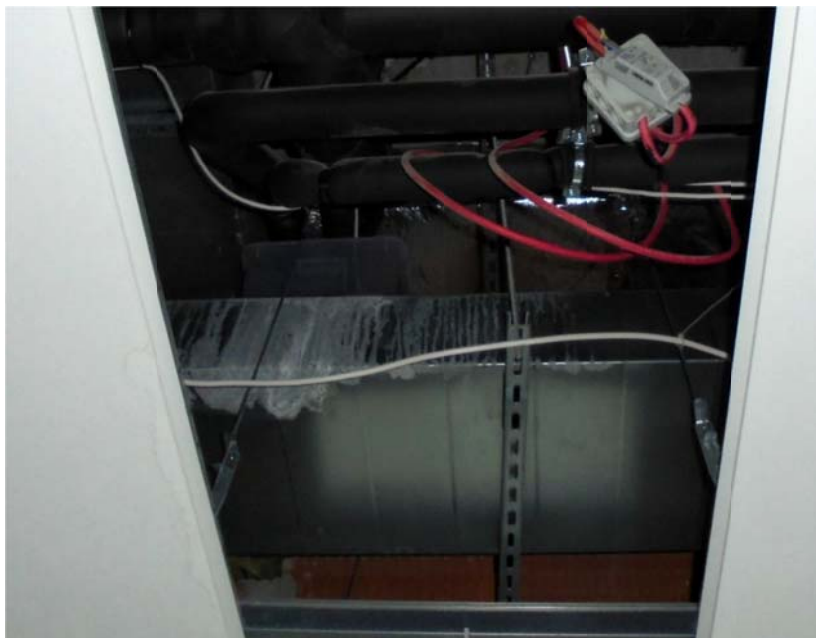
Fot.10 Zacieki na instalacjach nad korytarzem
