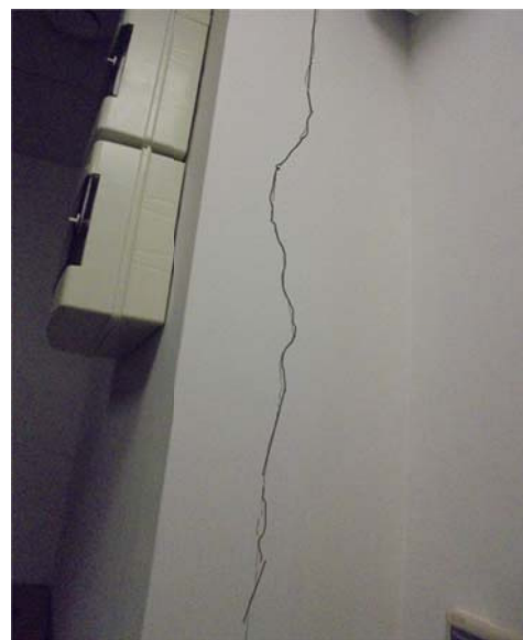
Fot.9 Rysa na ścianie szachtu
