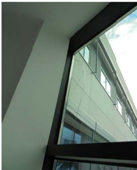
Fot.8 Pęknięta szyba (2 piętro)
