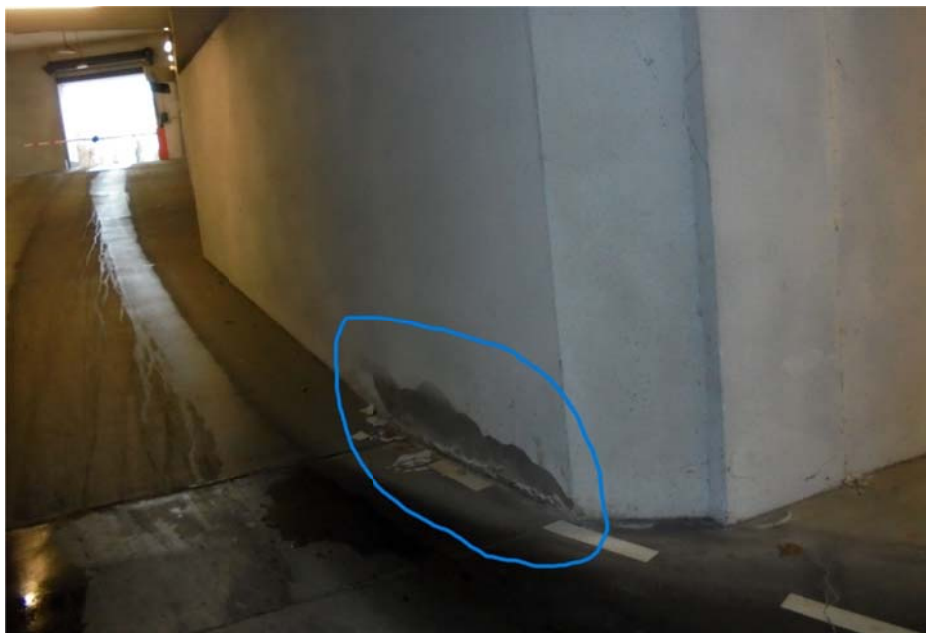
Fot.6 Podmakanie ściany przy wjeździe do garażu, woda spływająca po pochylni
