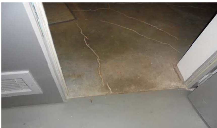
Fot.3 Rysy i wilgoć na płycie posadzkowej w wymiennikowni
