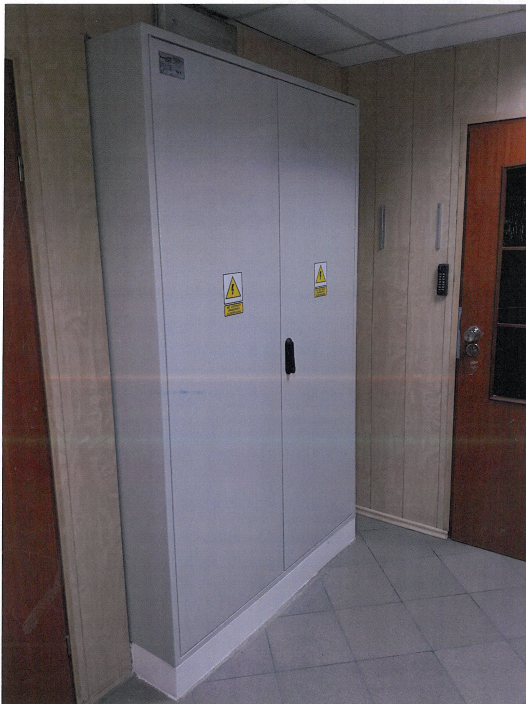
Zdjęcie 8.2 Tablica piętrowa wolnostojąca
