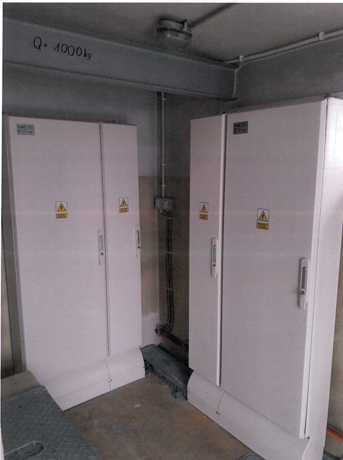
Zdjęcie 5.1 Rozdzielnice wentylacyjne RWA oraz RwB
