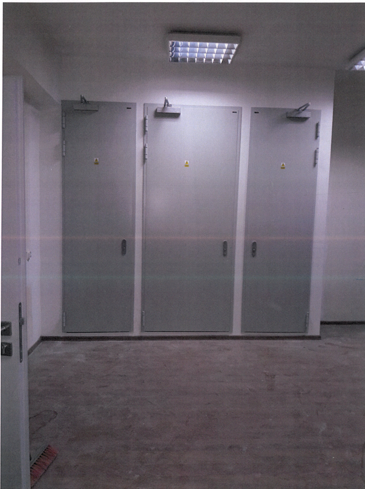
Zdjęcie 1.3 Drzwi stalowe przeciwpożarowe
