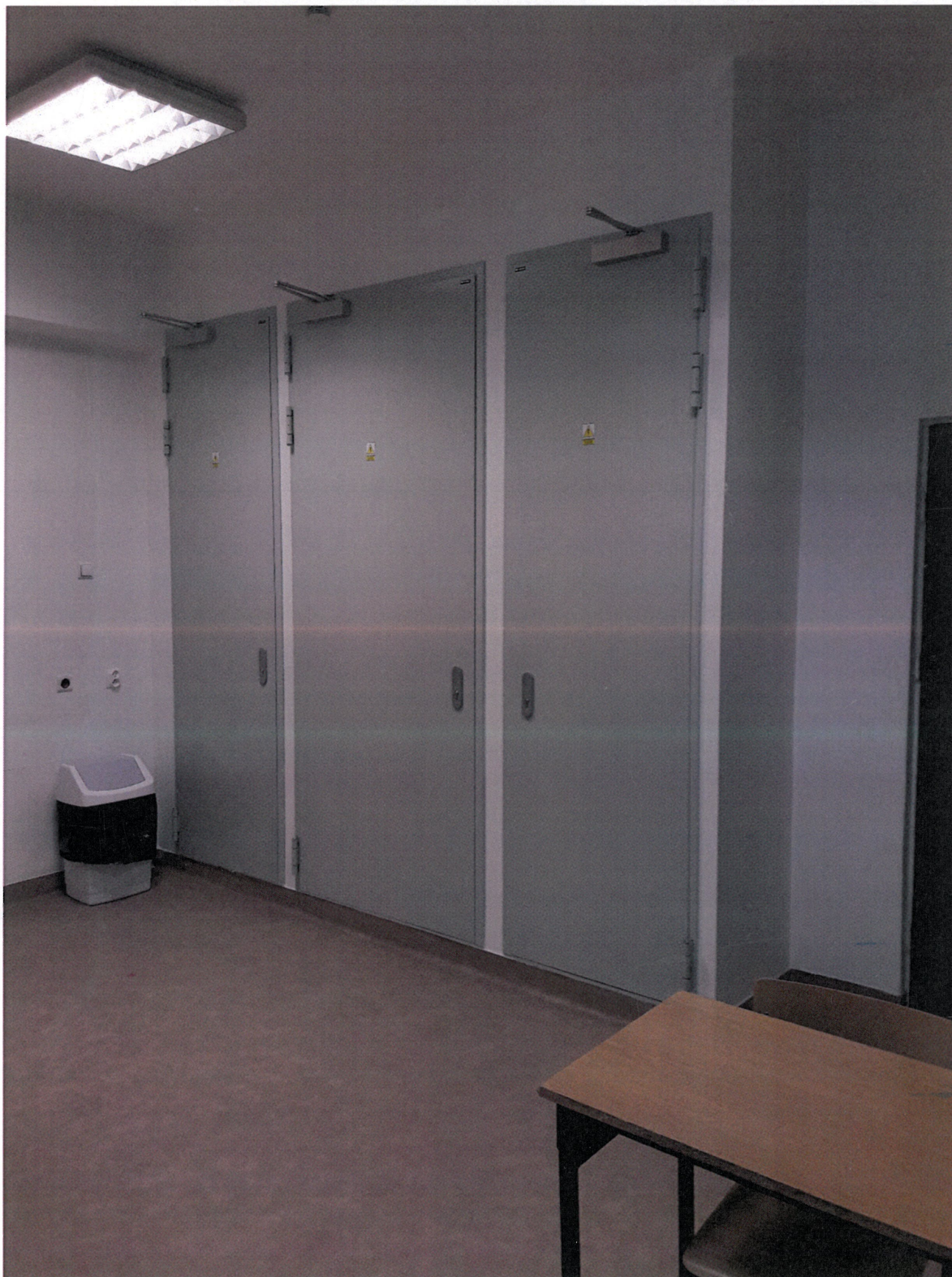
Zdjęcie 1.2 Drzwi stalowe przeciwpożarowe
