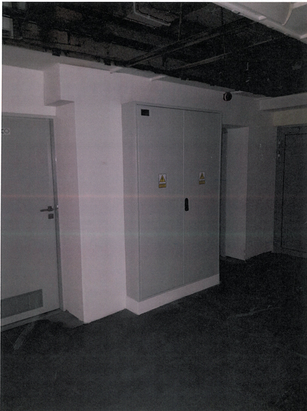
Zdjęcie 8.1 Tablica piętrowa wolnostojąca
