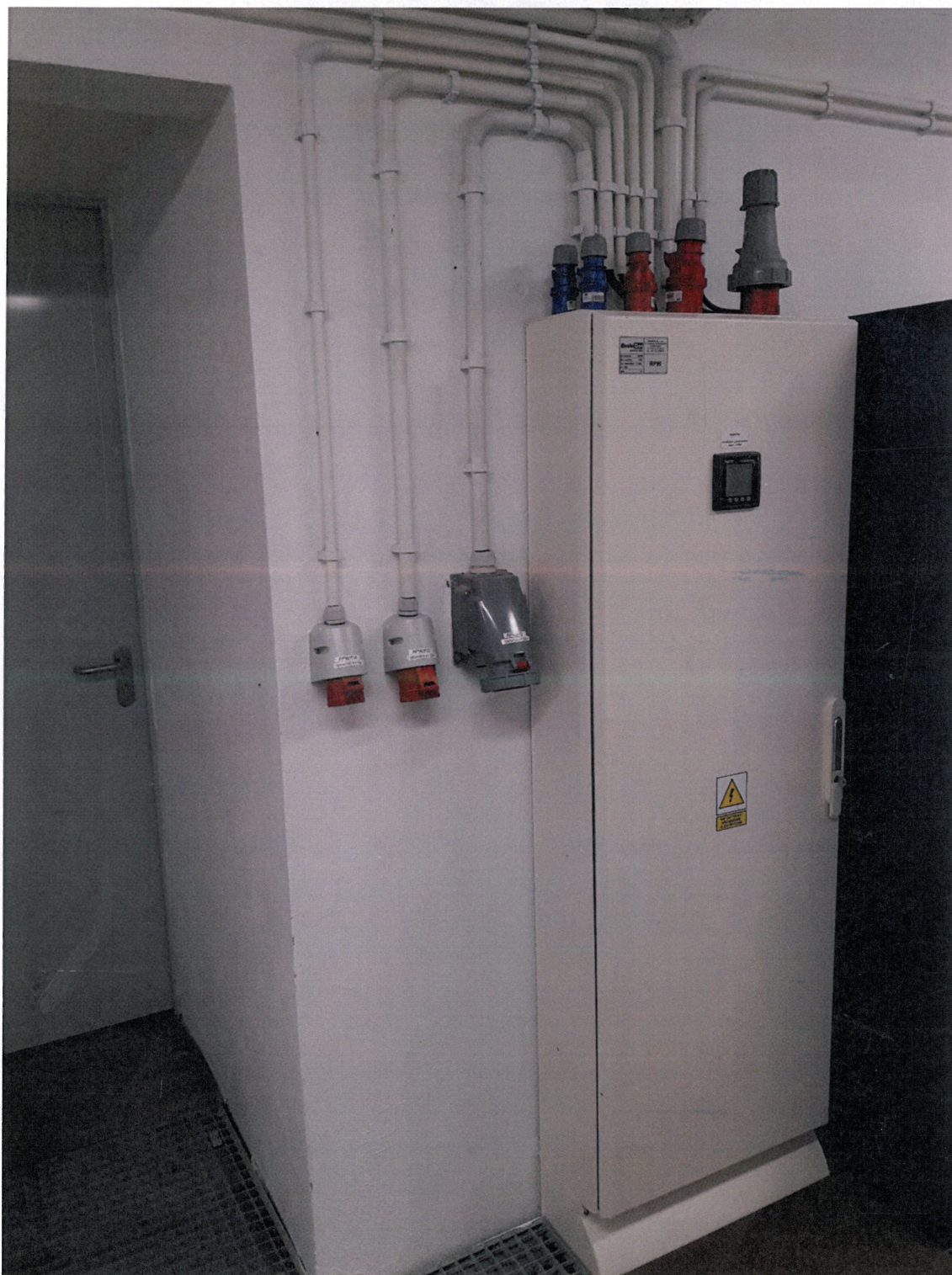
Zdjęcie 3.1 Rozdzielnica potrzeb własnych RPW
