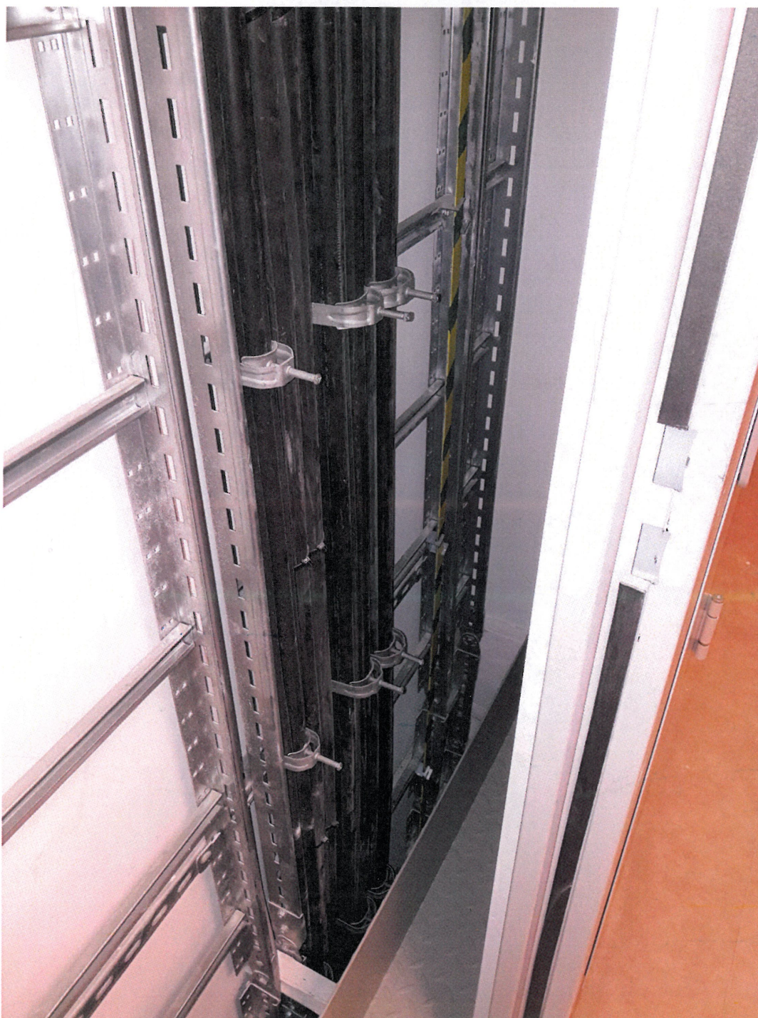
Zdjęcie 10.1 Trasy kablowe oraz wewnętrzne linie zasilające (szacht kablowy)
