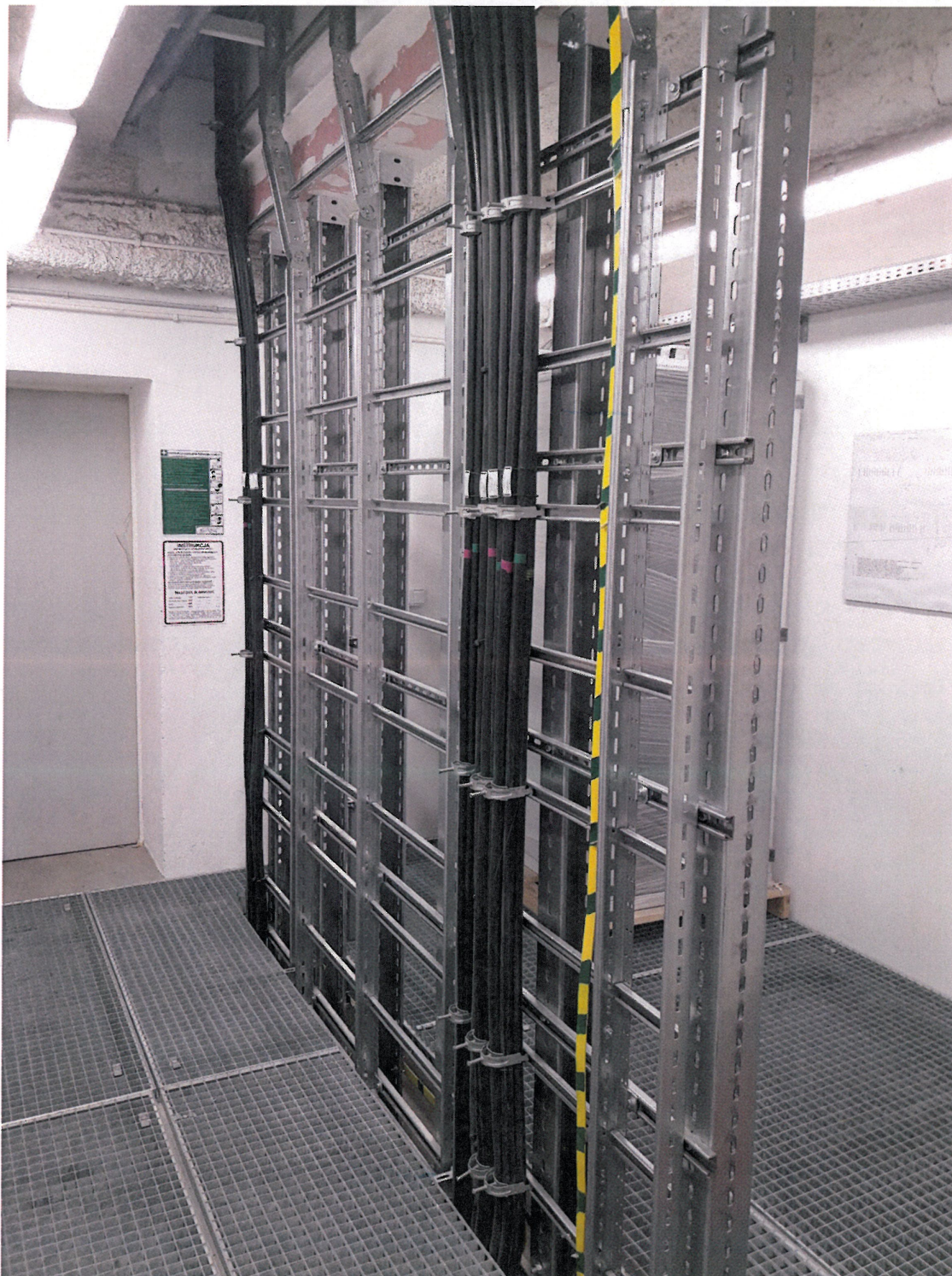
Zdjęcie 10.2 Trasy kablowe oraz wewnętrzne linie zasilające (pomieszczenie rozdzielnic RG1)
