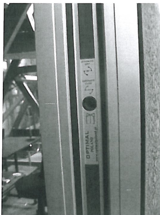
Fot.6. Pionowe listwy krawędziowe z mechanizmem blokującym
