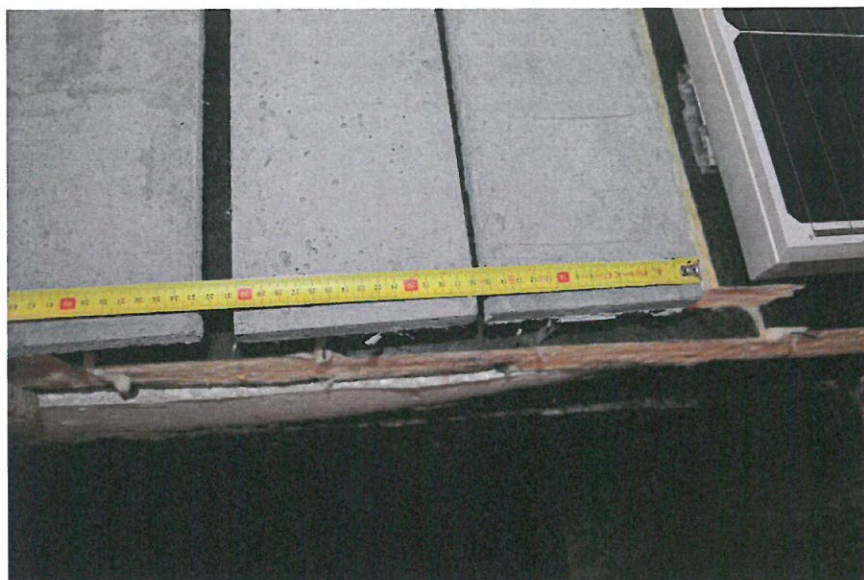
Rys. 20. Widok detali przed badaniem
