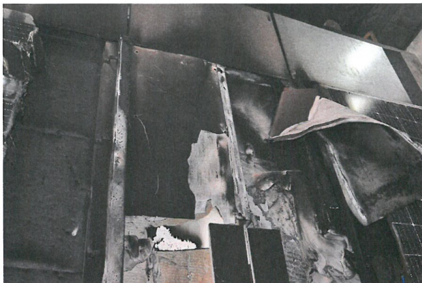
Rys. 44. Widok elementu próbnego po badaniu - detale
