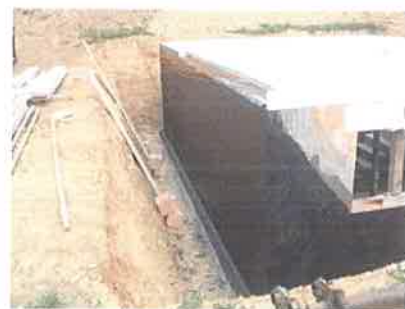
Uszczelnienie zewnętrznej ściany piwnicy z betonu przy zastosowaniu PCI Pecimor® 2K. Wygodna obróbka dzięki wypełnieniu polistyrenowemu.
