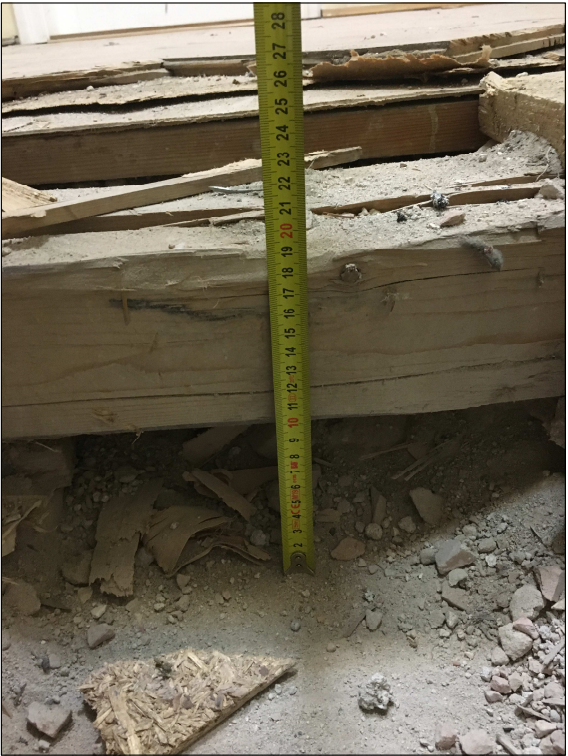
ODKRYWKA nr 1 widok na warstwę posadzki
