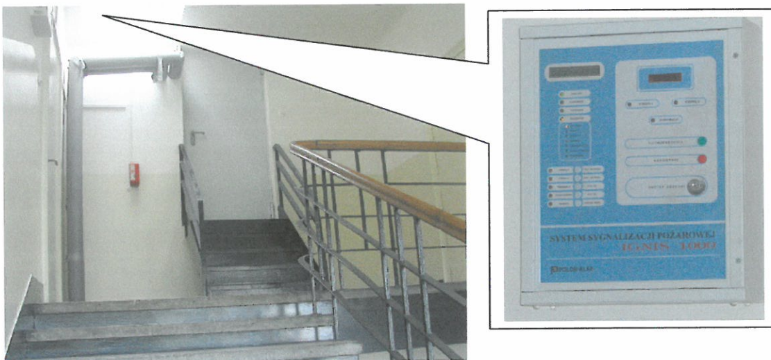
Rys. 3. Wymknięte pożarowo nieużytkowe poddasze. Klatka schodowa oddymiana grawitacyjnie.
