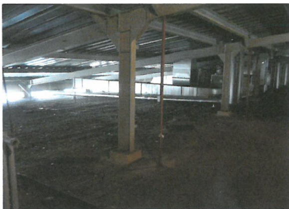
Rys. 2. Stropodach żelbetowy przykryty konstrukcją stalową z pokryciem blachy trapezowej.
