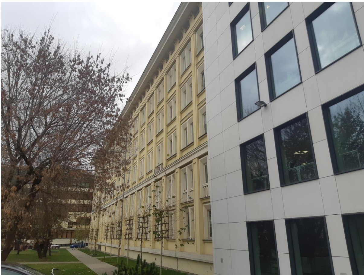
Zdjęcie nr 6 Widok od strony wschodniej – połączenie z budynkiem C6
