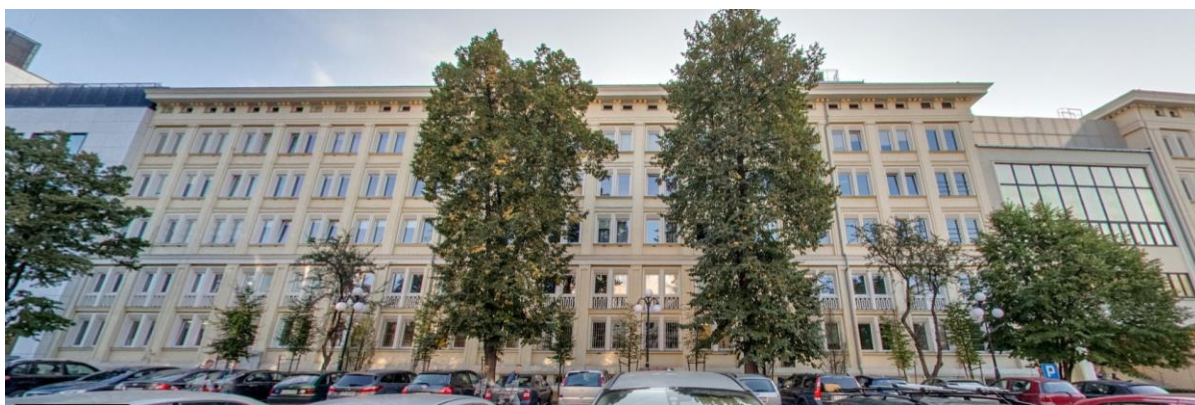
Zdjęcie nr 8 Widok od strony zachodniej – drzewa przed budynkiem
