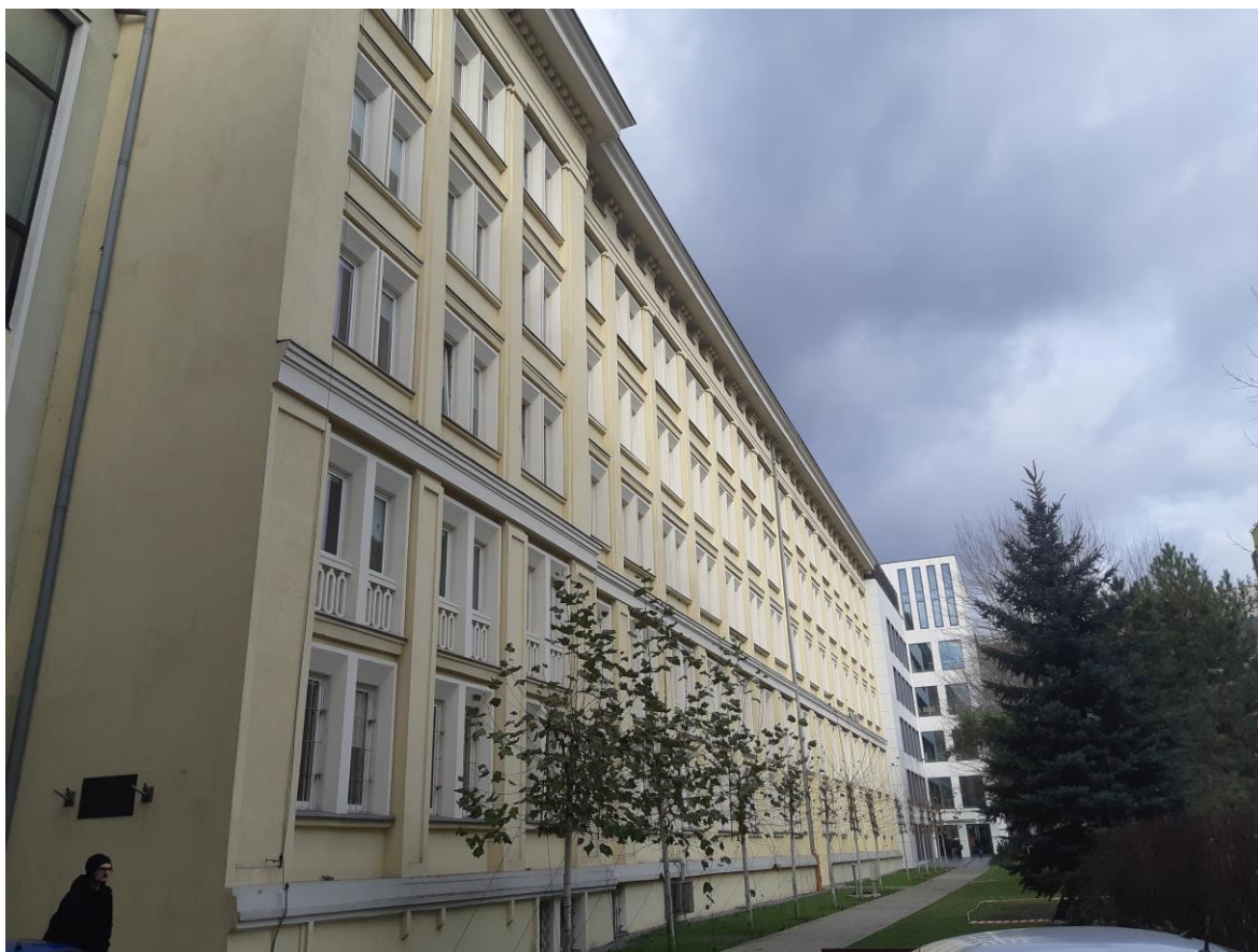
Zdjęcie nr 5 Widok od strony wschodniej
