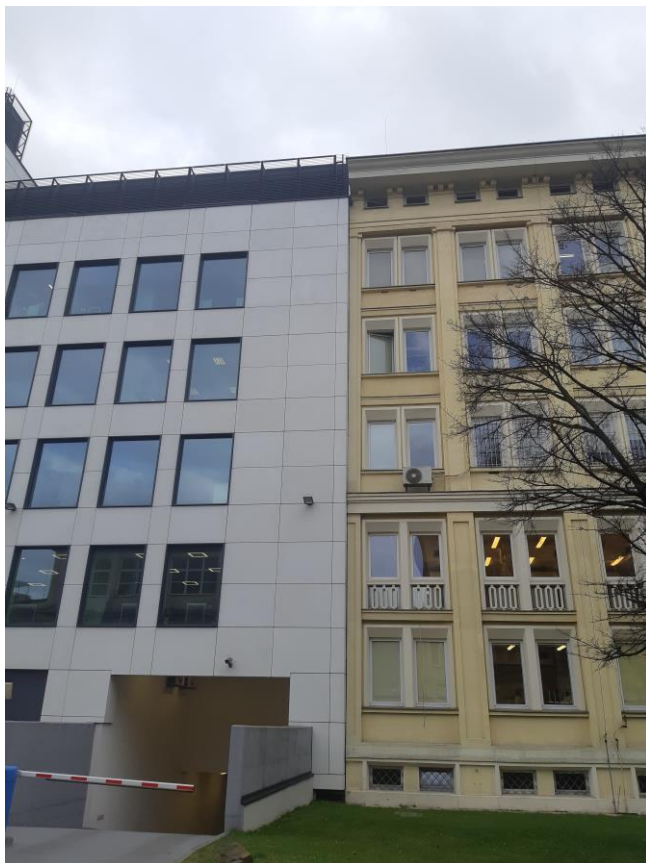
Zdjęcie nr 4 Widok od strony zachodniej – połączenie z budynkiem C6
