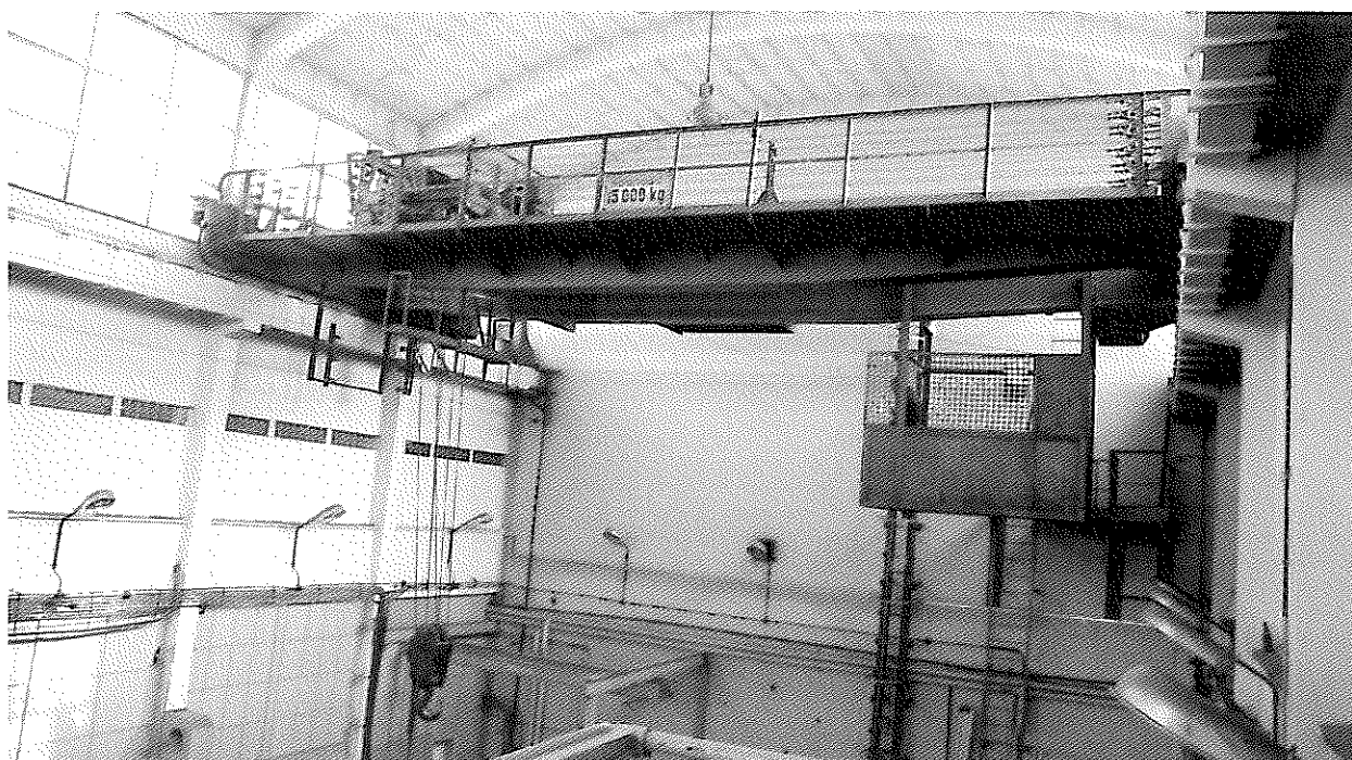
Fotografia 11 Widok w kierunku na ścianę w osi R10, widoczna suwnica.
