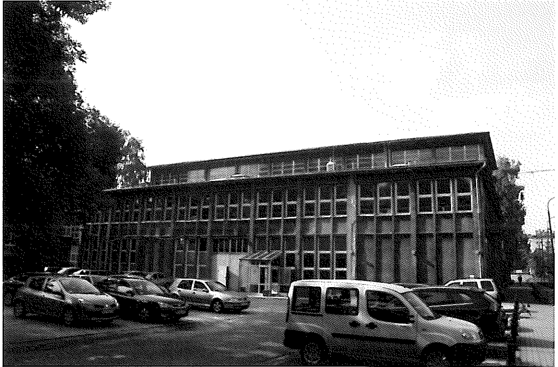
Fotografia 2 Widok na ścianę w osi A.
