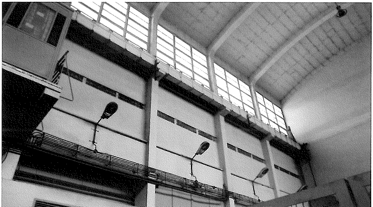
Fotografia 9 Widok w kierunku naroża R10/A.
