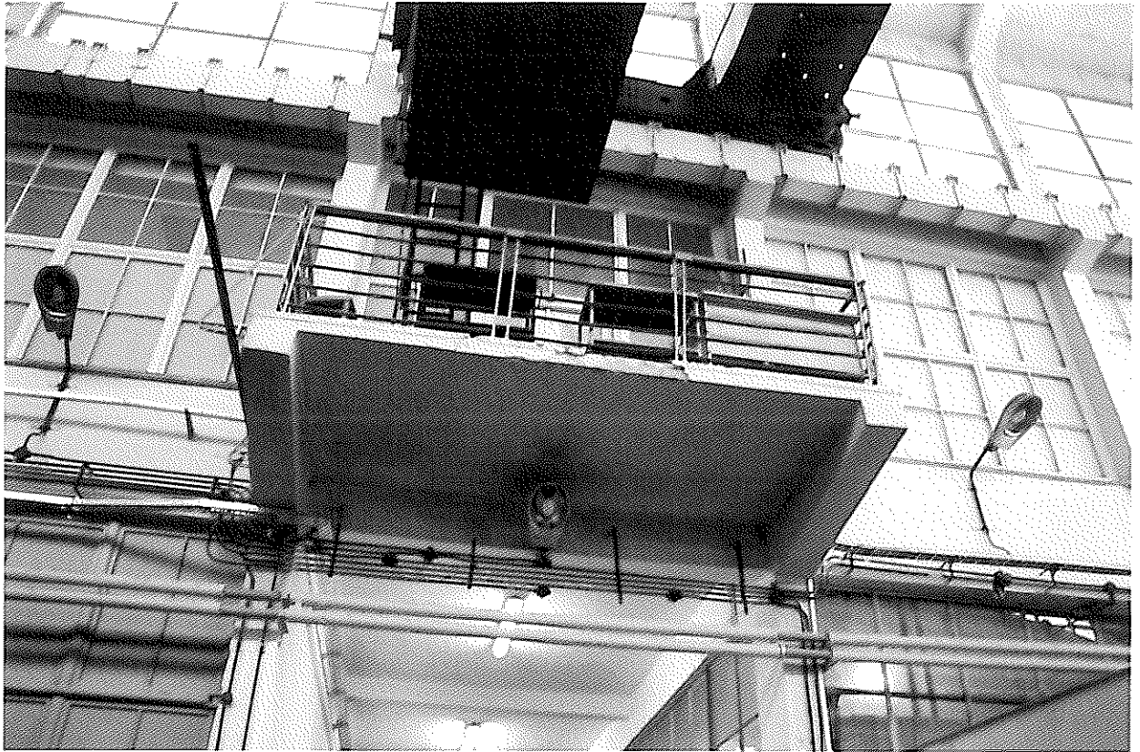
Fotografia 8 Widok na balkon wspornikowy na ścianie w osi C między osiami R5, R6.
