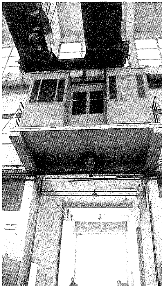
Fotografia 10 Widok na balkon wspornikowy na ścianie w osi B między osiami R5, R6.
