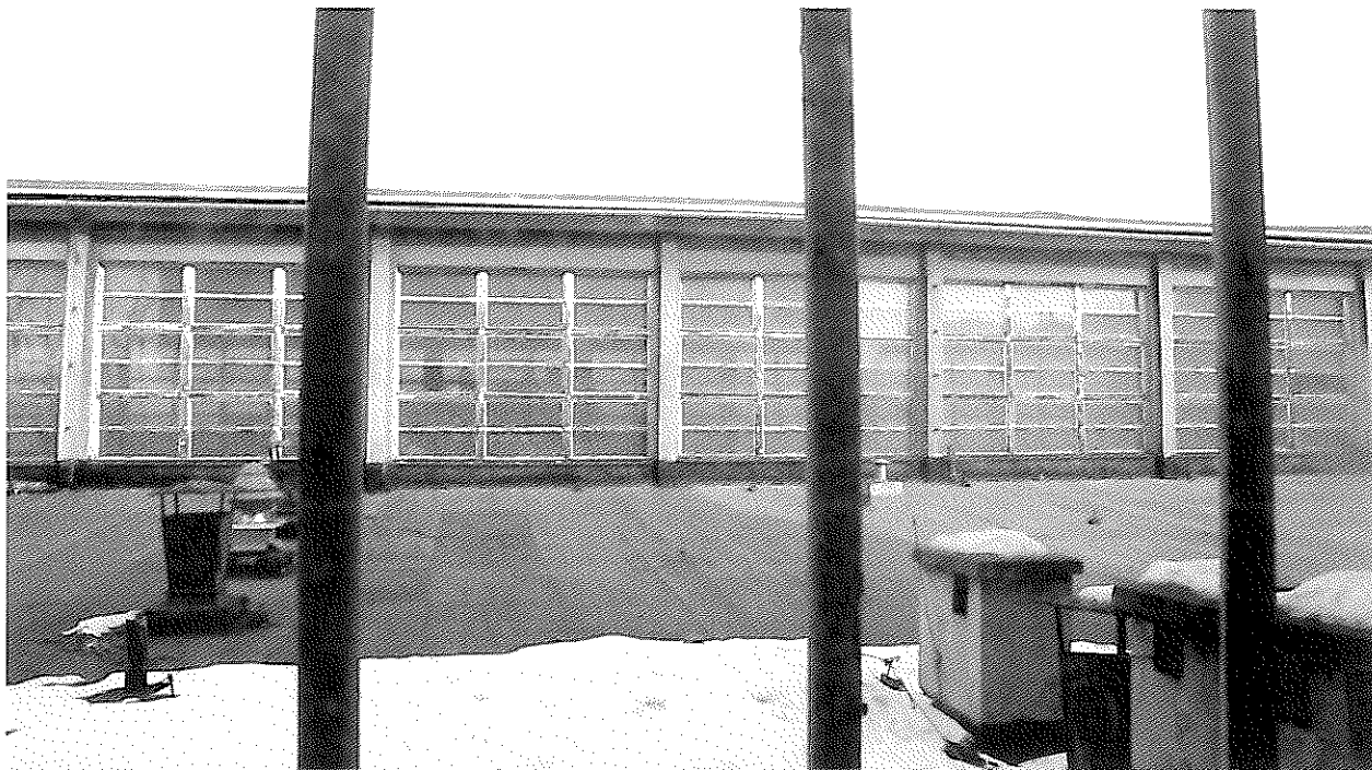
Fotografia 12 Widok na dach między osiami C i D, w tle ściana w osi C.
