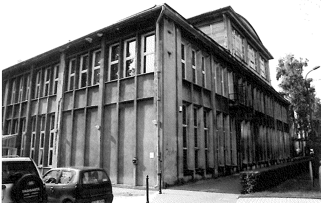
Fotografia 1 Widok na narożnik osie R1/A.
