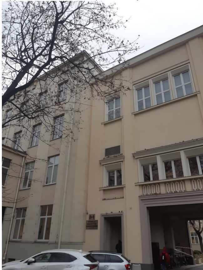
Zdjęcie nr 4 Widok od strony wschodniej – połączenie z budynkiem C1
