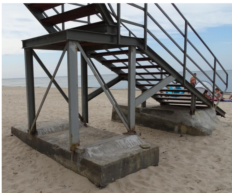
Słupowa podpora dolnej części kładki
