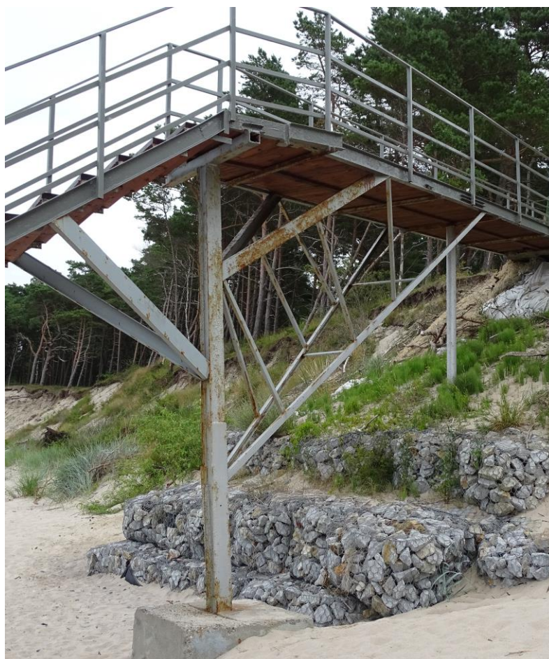
Słupowe podpory górnej części kładki – stan obecny
