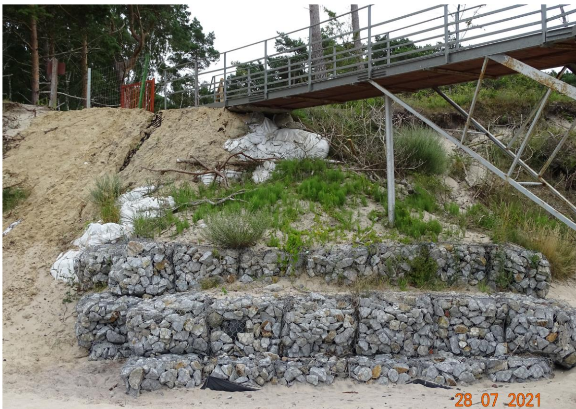
Widok zabezpieczenia skarpy klifu pod istniejącą kładką zejścia na plażę
