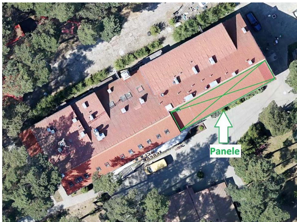
Widok dachu nad budynkiem
