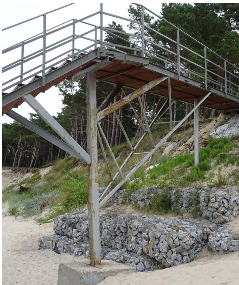
Słupowe podpory górnej części kładki – stan obecny
