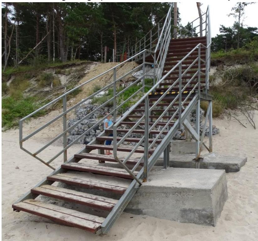
Widok biegów schodowych kładki - stan obecny
