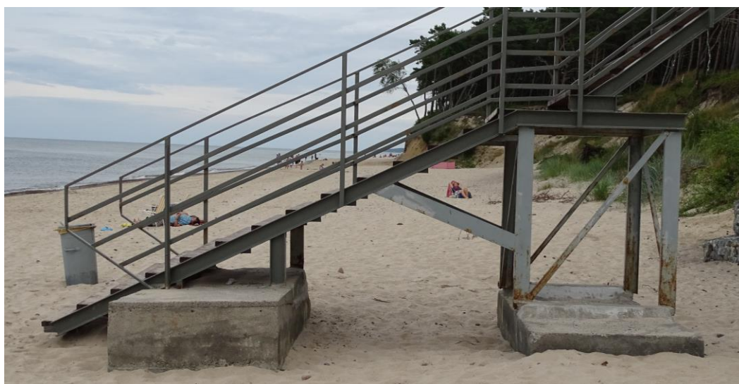
Widok fundamentów podpór dolnej części kładki – stan obecny
