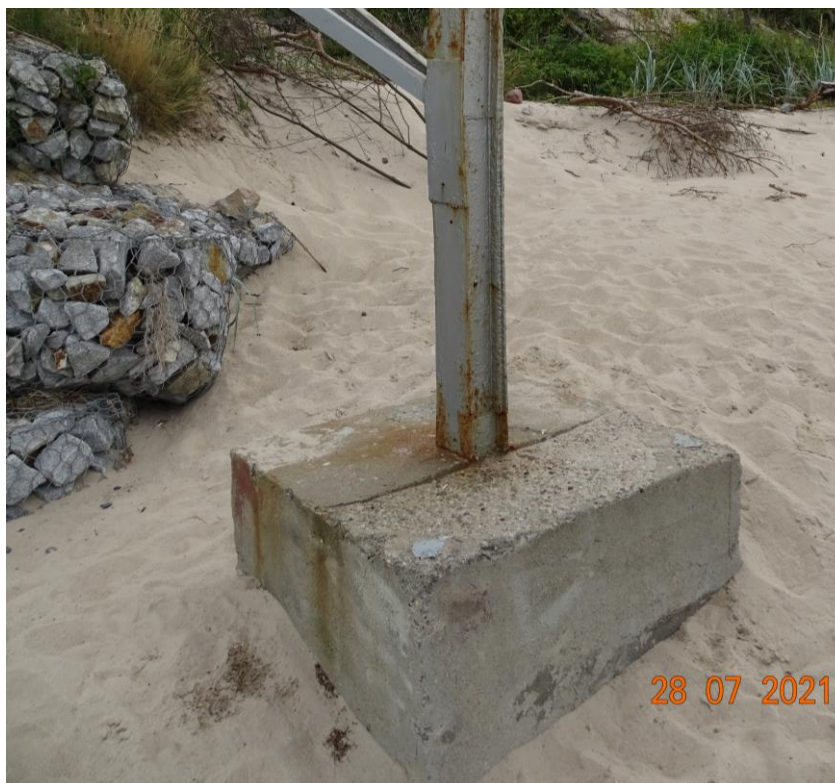
Widok fundamentu słupa podporowego górnej części kładki – stan obecny
