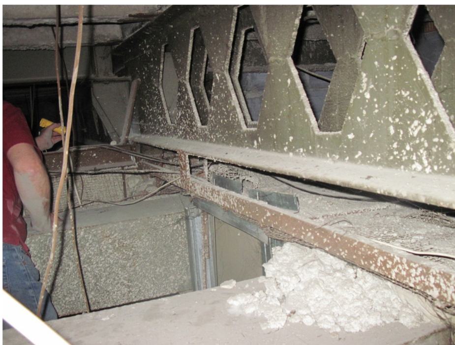
fot. 9 . Dźwigar B11 z dwóch belek ażurowych wys. 450 mm w osi III (2x rozsunięte IN 300). Oparcie na belkach ażurowych belki usztywniającej IN 300 (B24) biegnącej w osi B między osiami III-VI. Półka górna dwuteownika B24 znajduje się kilka cm poniżej poziomej płytki płyty korytkowej.
