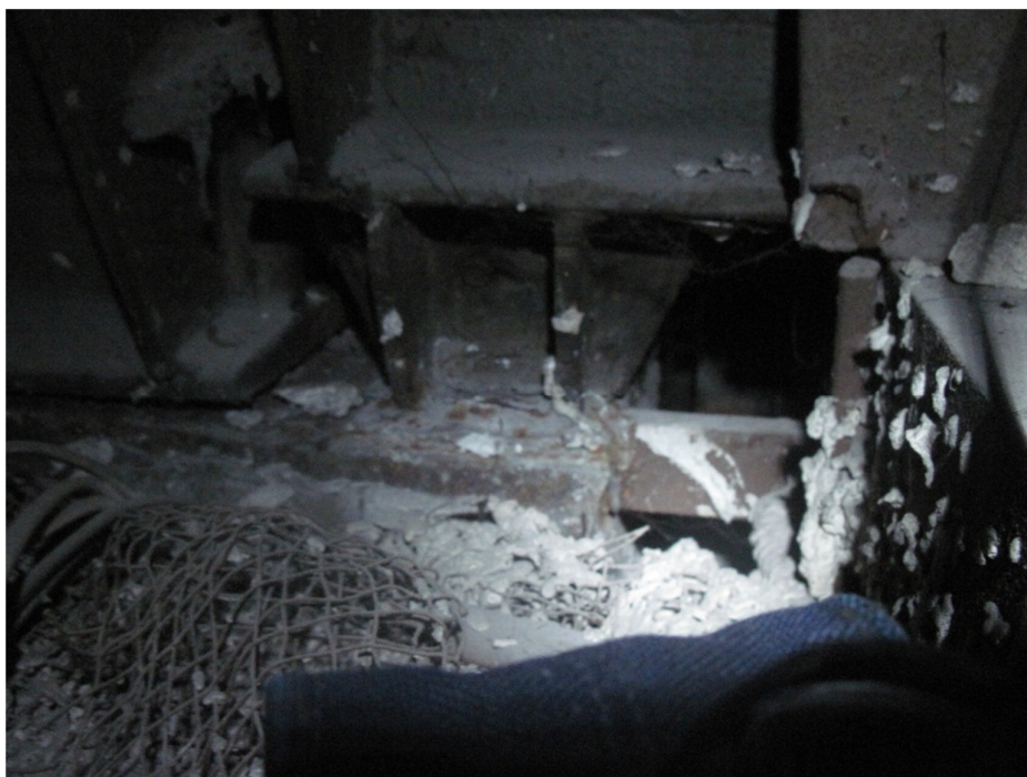
fot. 8. Oparcie ażurowych belek o wys. 540 mm (B6) i 450 mm (B11) na słupie żelbetowym
