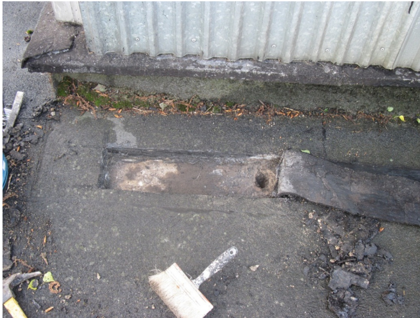
fot. 1. Odkrywka w połaci dachu przy północno-wschodnim narożniku części wyższej
