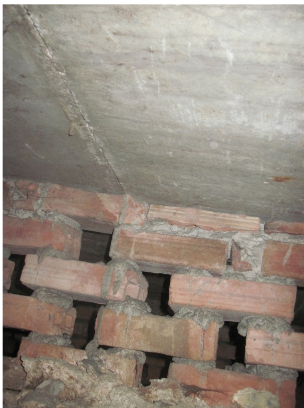
fot. 4. Widok przestrzeni wentylowanej stropodachu
