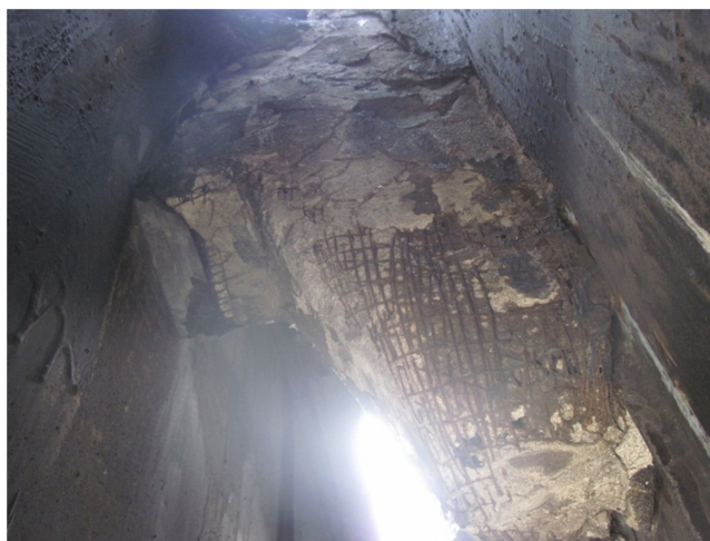
fot. 20, 21 Popękany, ze znacznymi ubytkami tynk na korodującej siatce Rabitza, osłaniający stalowe wsporniki dla attyk biegnących wzdłuż południowej i północnej krawędzi dachu części wyższej
