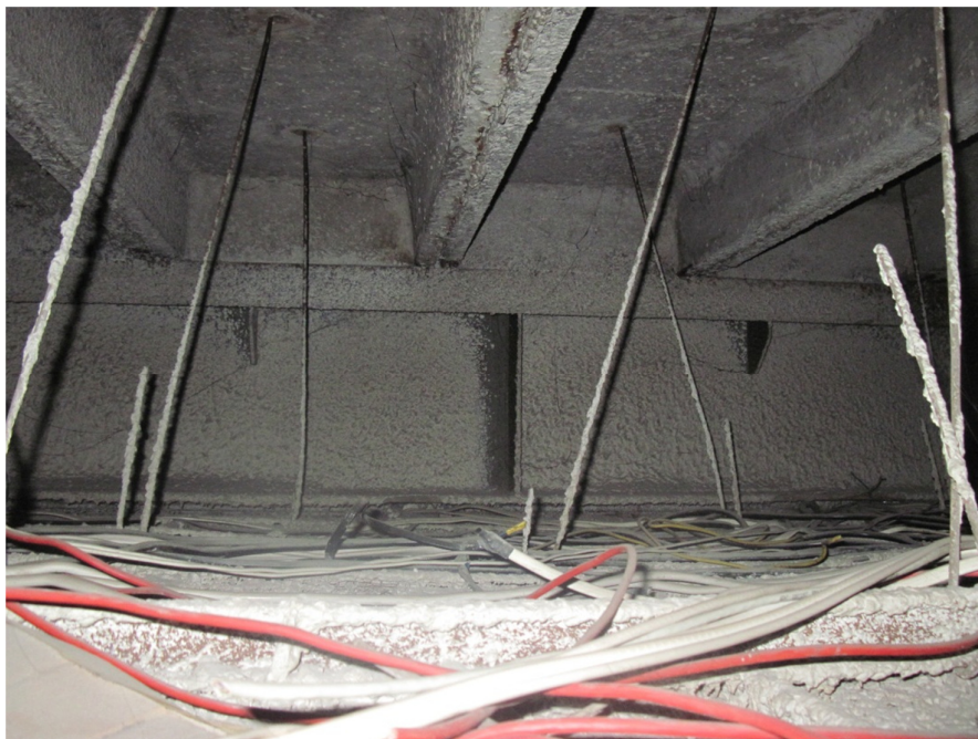
fot. 12. Oparcie płyt stropowych na blachownicy Pd2 wys. 155 cm w osi III (zgodne z projektem)
