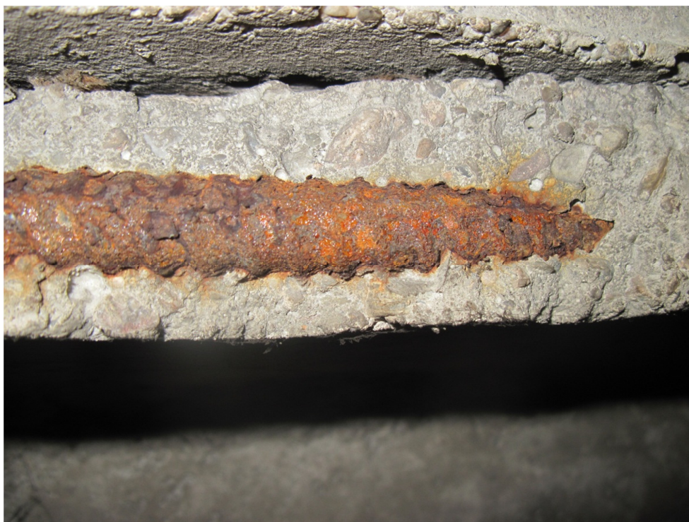
fot.3. Zbrojenie żeberka płyty korytkowej- 1#14 (A-III)
