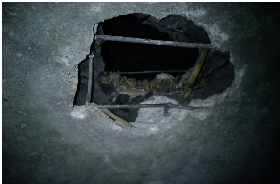
fot. 2. Odkrywka w korytkowej płycie stropowej dł. 6 m (między osiami 3-4/B-C)
