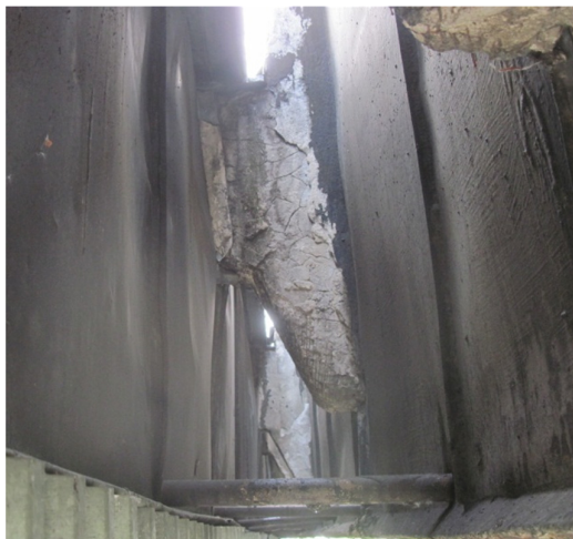
fot. 20, 21 Popękany, ze znacznymi ubytkami tynk na korodującej siatce Rabitza, osłaniający stalowe wsporniki dla attyk biegnących wzdłuż południowej i północnej krawędzi dachu części wyższej
