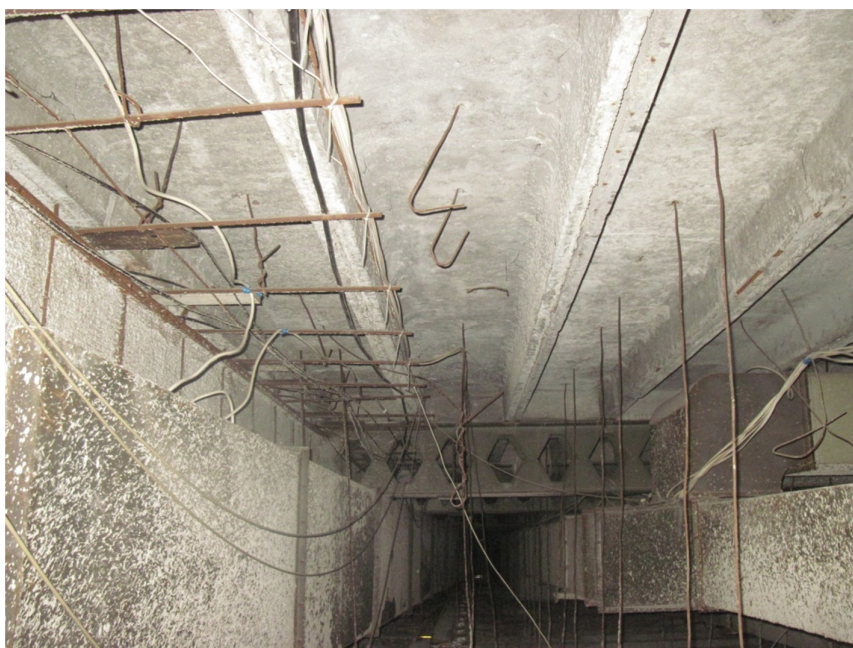
fot.11. Oparcie płyt stropowych na dźwigarach ażurowych
